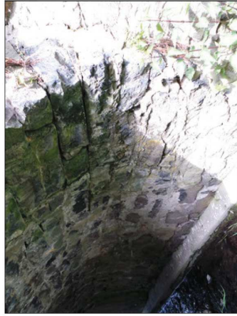
Pohled na OP2 zprava - vydolená malta v úrovnl čelnl zdl, sílnce na zdlchl prvchl
