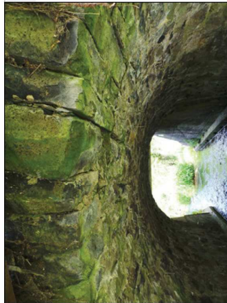
Pohled na vrchol klenby zprava - inkrustace, výlupy, vypadané spárování ve vrcholu klenby
