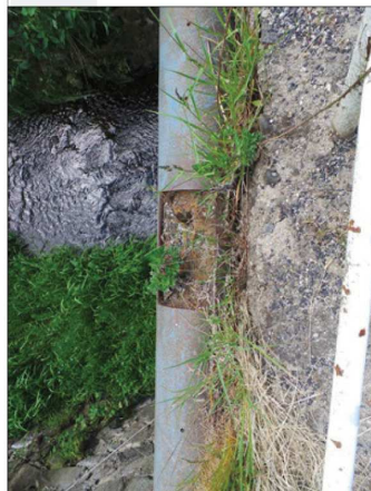
Výslek na chráničce vodorodu vpravo - vegetace mezi chraníčkou a římsou, v lepatě izolaci uchycená vegetace, povrchová degradace římsy
