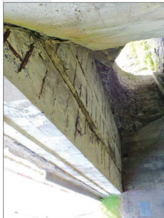
Pohled na NK rozšířené části - nedostatečná krycí vrstva ŽMP prefabrikátů, obnažená smyková výztuž, odtržená hrana krajního nosníku, inkrustace mezi ve spárách mezi nosníky
