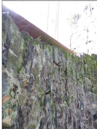
Pohled na NK v úrovni čelní zdi - lokálně vypadané spárování, uchycené sítnice
