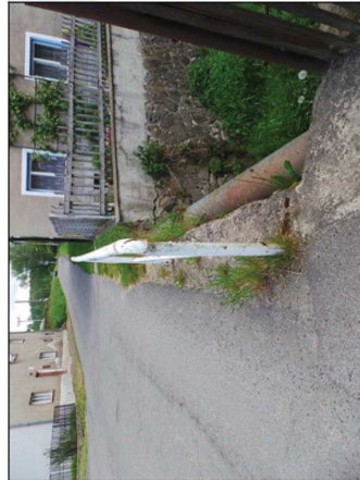
Pohled na pravou římsu - vegetace mezi vozovkou a římsou, vegetace mezi chráničkou a římsou, povrchová koroze chráničky
