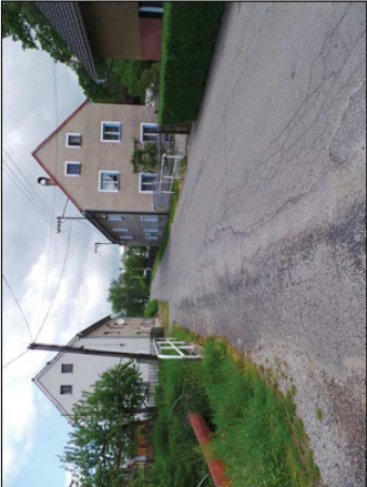
Pohled ve směru staničení - trhlíny ve vozovce, vegetace v krajnici
