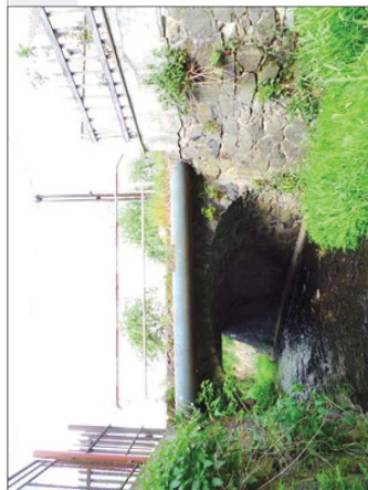
Pohled zprava na vltoku - zpořádkl klenby, uchylenl vegealace v čelnl zdl, výsek v chránlce vodovodu
