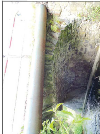
Pohled na OP2 zprava - začlnal koroze chránlky vodovodu, vegealace v čelnl zdl, inkruaalce, výluhy malty, vydolená malta v úrovnl čelnl zdl
