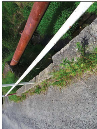
Pohled na levou římsu - vegetace uchycená mezi římsou a vozovkou
