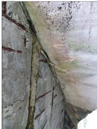
Pohled na uložení NK na OP1 - inkrustace v místě uložení, uchycené sítnice
