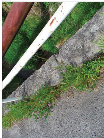
Koroze zábradlí
