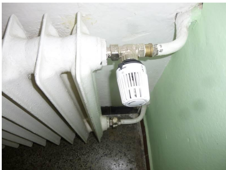
Foto č. 8 Radiátor s TRV hlavicí v objektu č. 1
