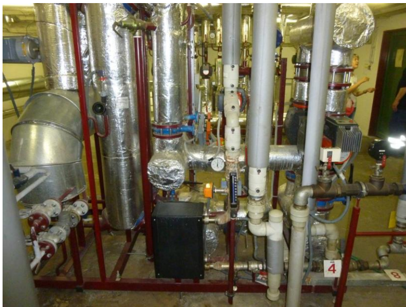
Foto č. 7 Dopravní podnik Ostrava a.s., - výměník v PS2
