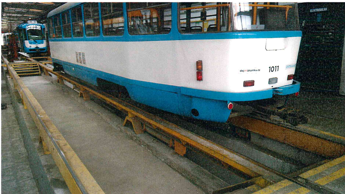
Obr. č. 3 Stávající stav kolejiště
