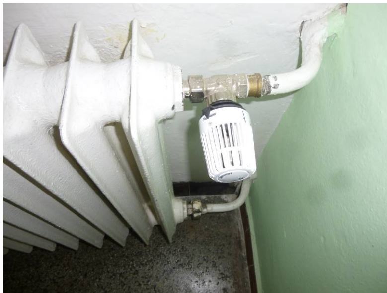
Foto č. 8 Radiátor s TRV hlaví v objektu č. 1
