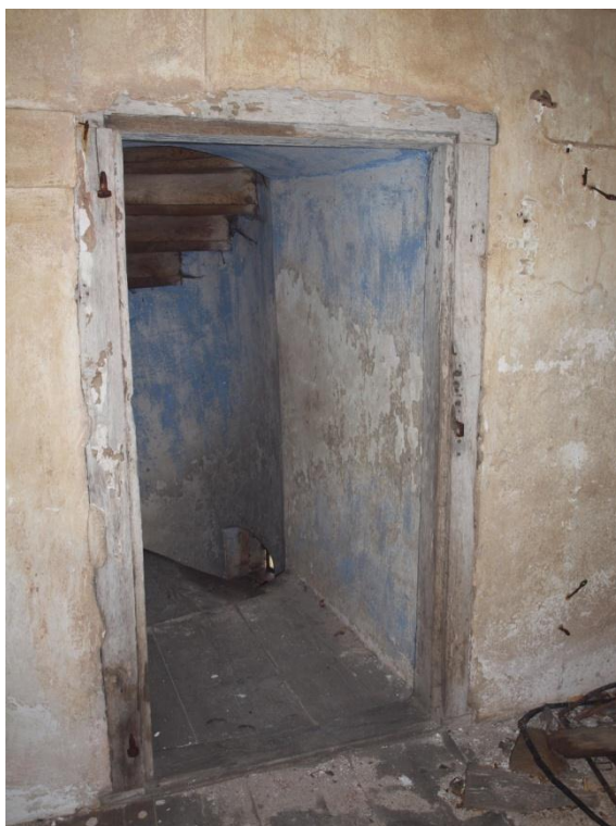
Pohled na zárubeň dveří H z kruchtě na schodiště.
