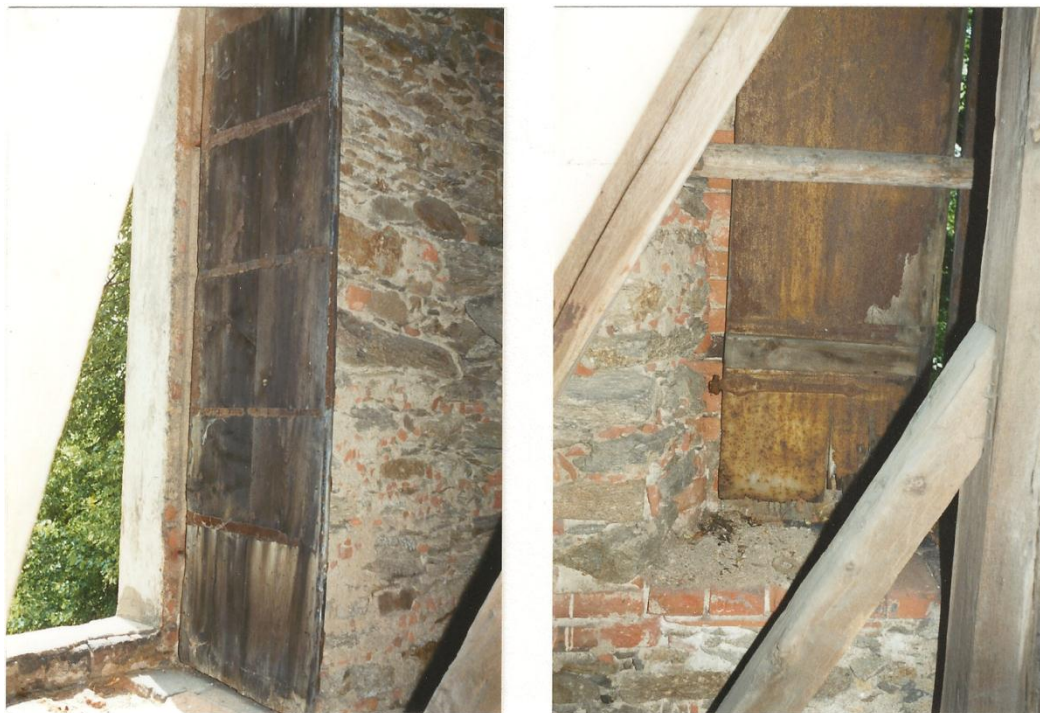
Pohled vnější na okenici zvonice č. 14 a pohled vnitřní na okenici č. 15.
