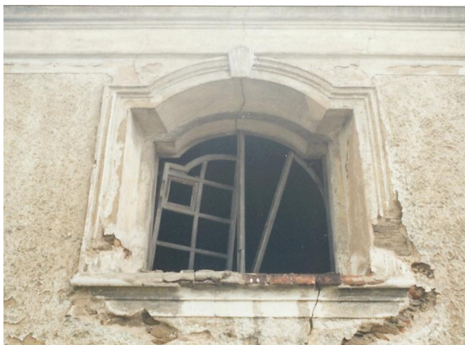
Pohled vnější na okno č. 7
