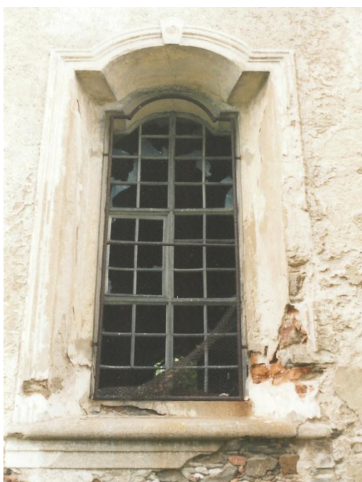
Pohled vnější na okno č. 6.
