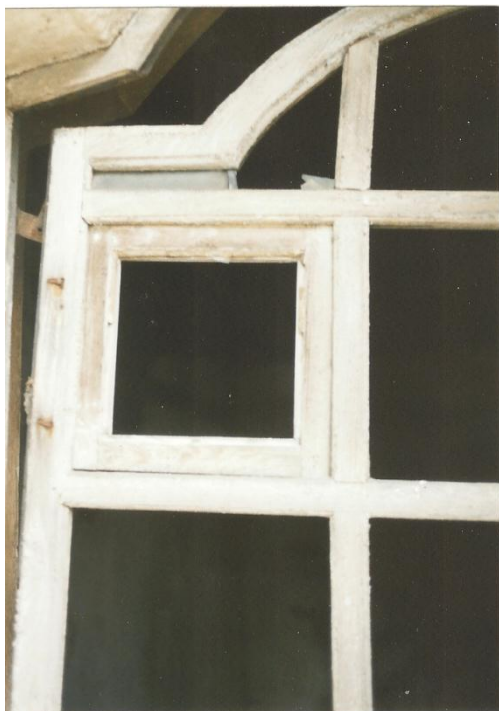
Detail větracího křídla v okně č. 7
