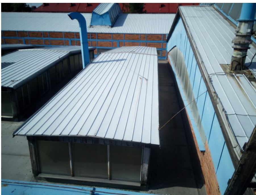
Obrázek 2 - Přejechod snížené části střechy na zvýšenou
