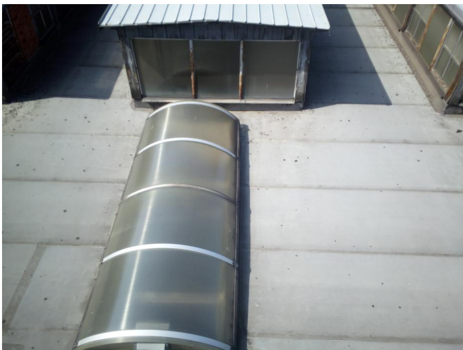
Obrázek 4 - Světlíky na snížené části střechy
