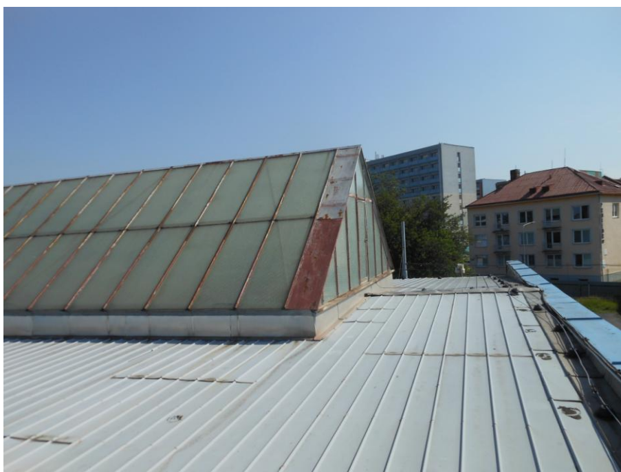
Obrázek 2 - Sedlový světlík a hřeben střechy
