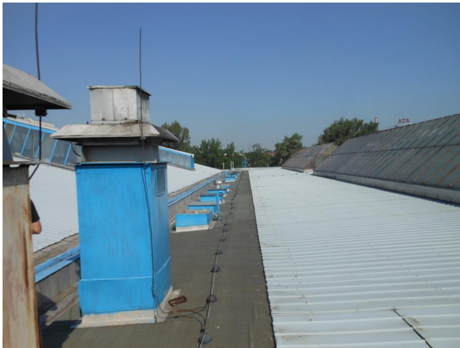
Obrázek 3 - Odstraňované bodové světlíky a VZT hlavice
