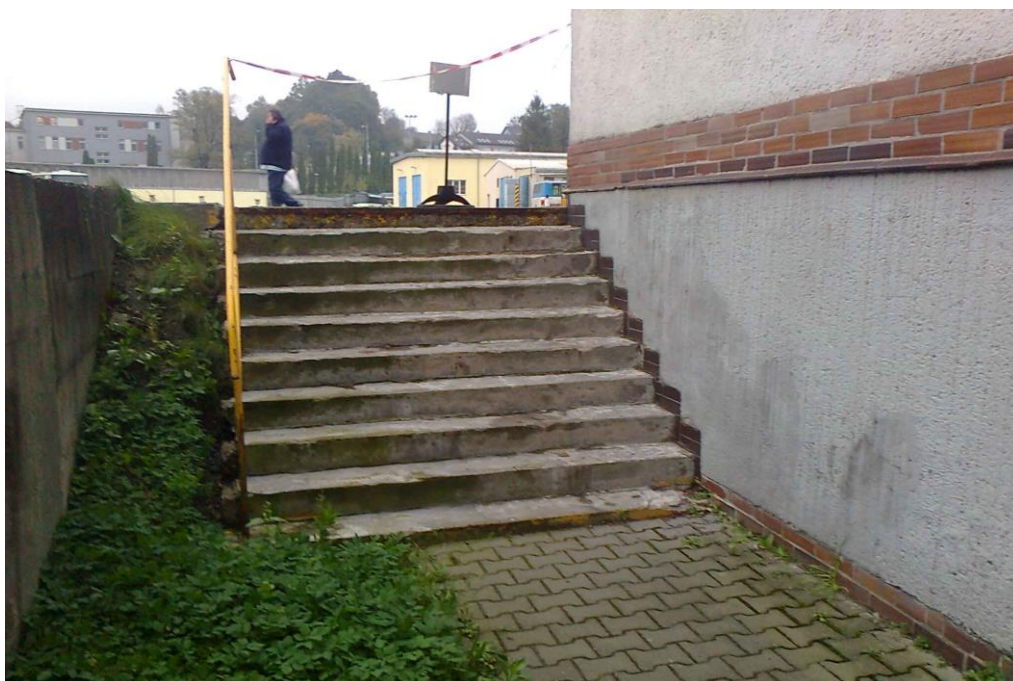
Schodiště šířky 2,0 m-vybourat a nahradit novým. Nad schodištěm je patrná mokrá omítka- odsekat. Nové schodiště bude š. 1,20. Na levé straně bude zatravněný svah kopírující sklon schodiště. Na schodišti bude nové zábradlí, vlevo dle původní polohy.
