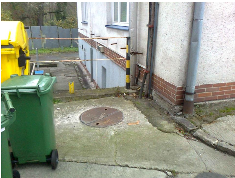
Čelní stěna-detail levého rohu. Kabely vedoucí do země. Není známa jejich poloha v zemi ! Odsekát kabřinec a znovu provést.
