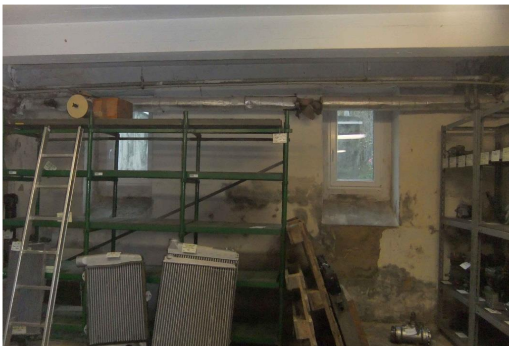
Stěna v místnosti č. 07. Opadaná malba a lokálně i omítka do úrovně terénu
