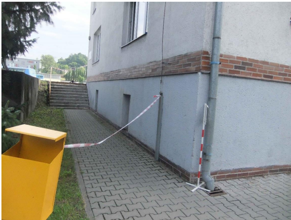
Pohled na pravou boční stěnu. V pozadí schodiště (vybourat a nové). Odstranění zámkové dlažby a odsekání kabřince nad chodníkem + nový výšky 40 cm
