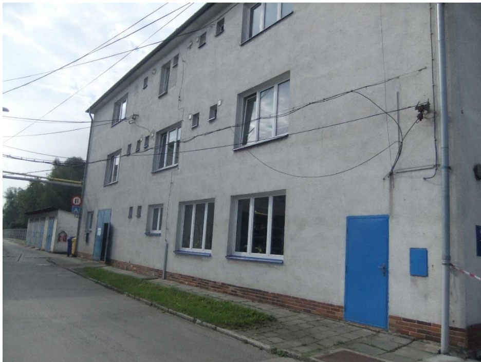
Čelní stěna. Odstranění dlažeb, odsekání kabřinců+ nové keramické obklady soklu. Provizorní lávka přes výkop ke vratům do skladiště. Dveře v popředí nebudou používány.
