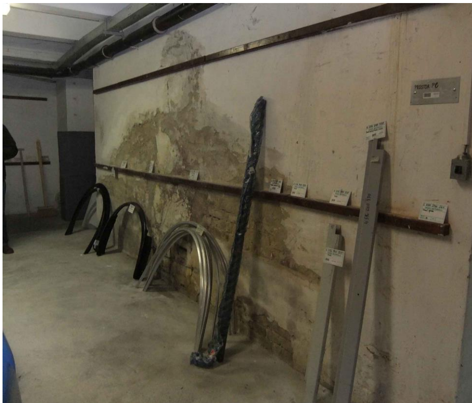
Místnost č 05. Voda zatečená do nefunkčního komínu u vnitřní stěny.
