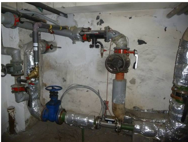
Foto č. 5 Napojovací uzel rozvodu tepla
