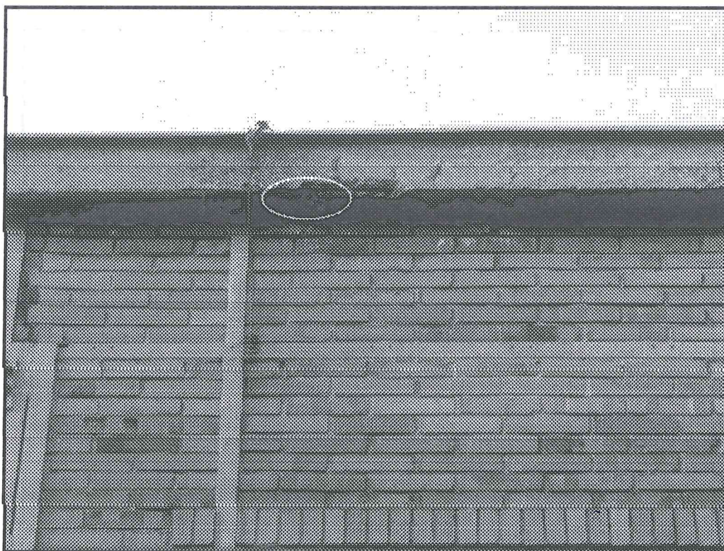
Obr. 4: Menší dutina ve zdivu pod okrajem střechy (elipsa) na SZ straně haly III – potenciální stanoviště netopýrů
