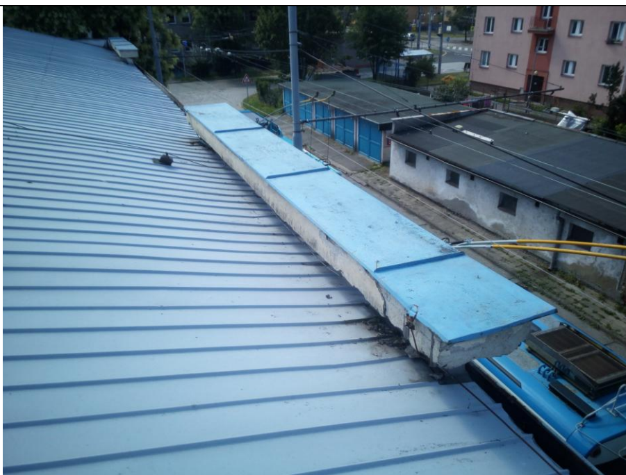
Obrázek 2 - Pohled na bouranou atiku
