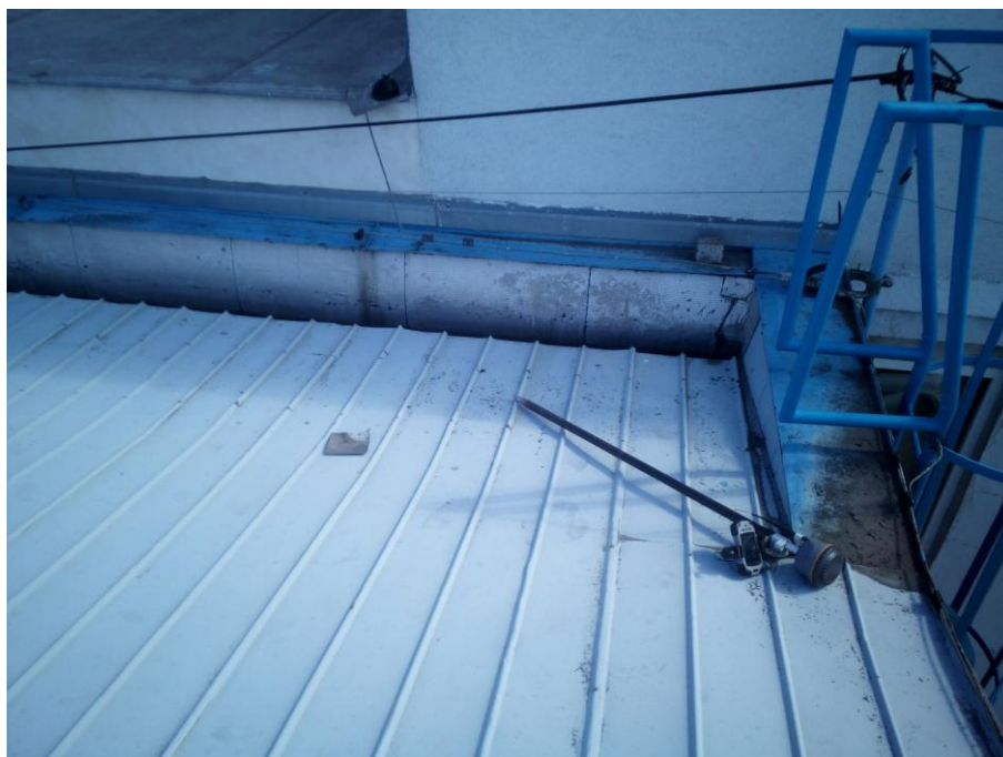
Obrázek 4 - Atika objektu a žebřík - Atika bude zvednuta a žebřík bude přizpůsoben navýšení atiky
