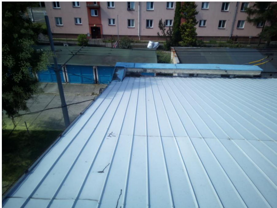
Obrázek 3 - Dlouhá část atiky (na podélné straně objektu) bude bouraná, atika na štítě bude zachovaná
