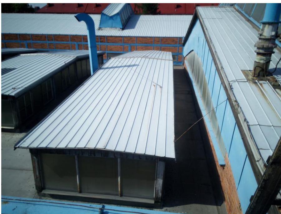
Obrázek 2 - Přejechod snížené části střechy na zvýšenou
