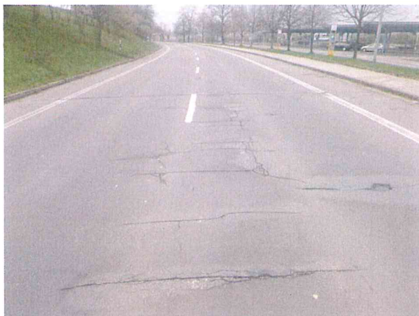
Ztráta makrotextury, mozaikové trhliny, výtluk, vysprávk
