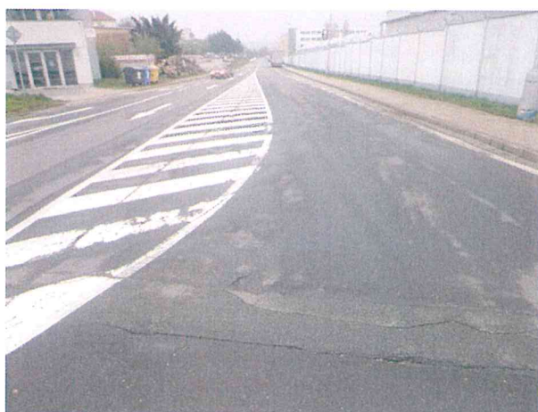
Příčná rozvětvená trhlina, vysprávký
