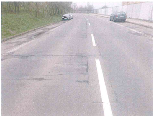
Ztráta makrotextury, příčné a podélné trhliny, vysprávk
