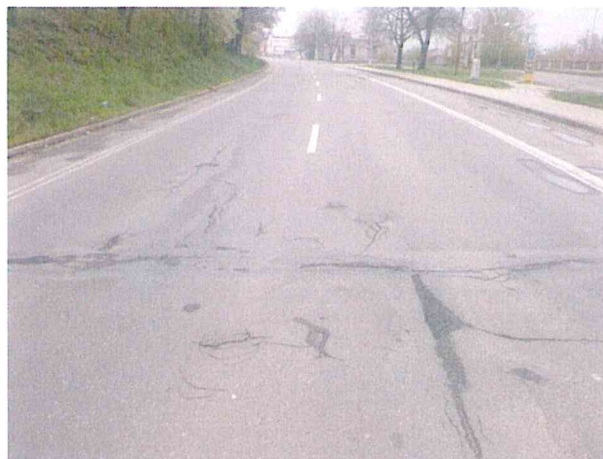
Ztráta makrotextury, mozaikové trhliny, vysprávk
