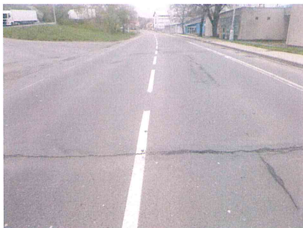
Příčná a podélné trhliny, vyjeté koleje
