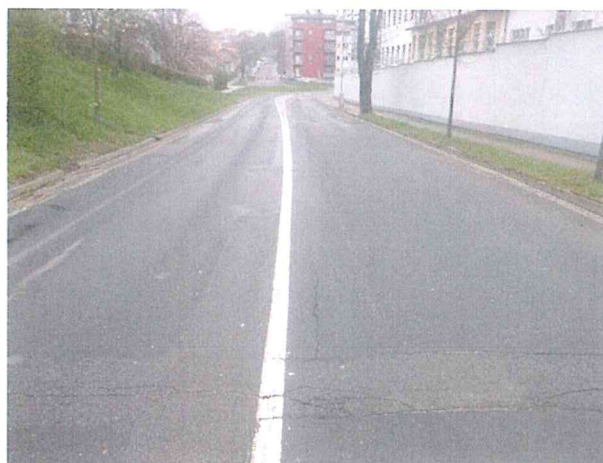
Příčná rozvětvená trhlina, vysprávký
