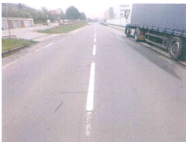
Ztráta makrotextury, začínající příčné trhliny
