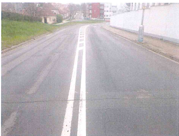
Příčná trhlina, mozaikové trhliny, vysprávka
