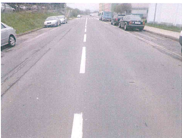
Ztráta makrotextury, mozaikové trhliny
