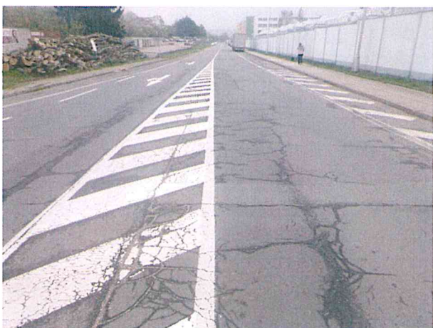
Ztráta makrotextury, mozaikové trhliny, vysprávký
