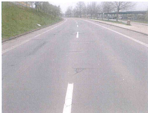
Ztráta makrotextury, mozaikové trhliny
