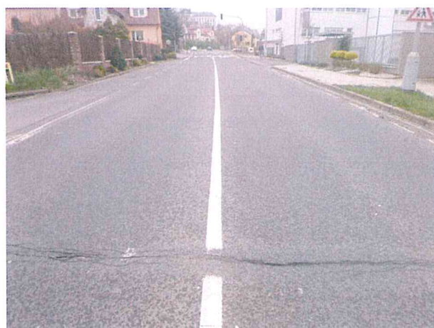
Příčná rozvětvená trhliny, vyjeté koleje
