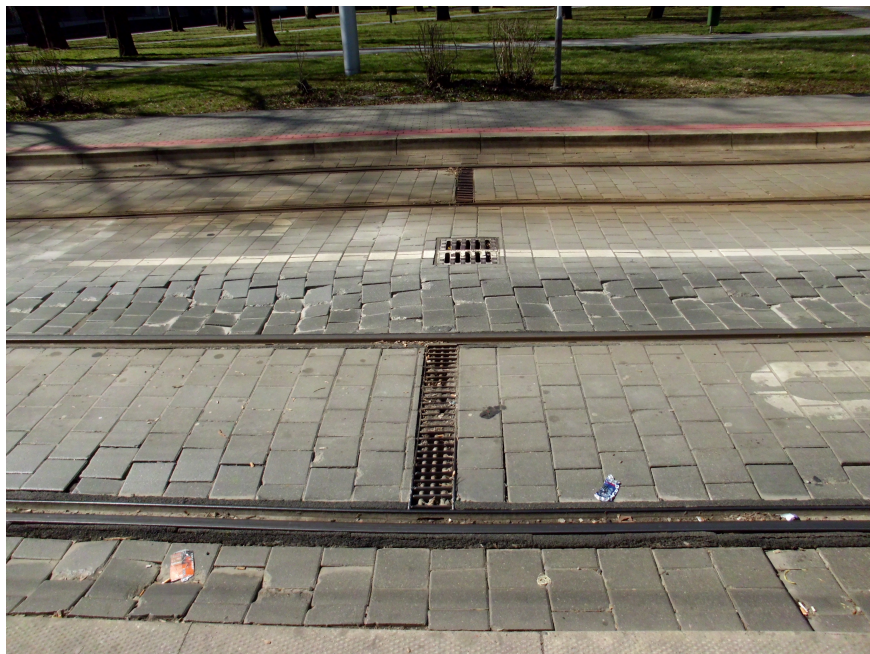
Foto č.7 – Sad Boženy Němcové - Pohled na deformaci krytu tramvajové tratě a kolejové odvodňovače.
