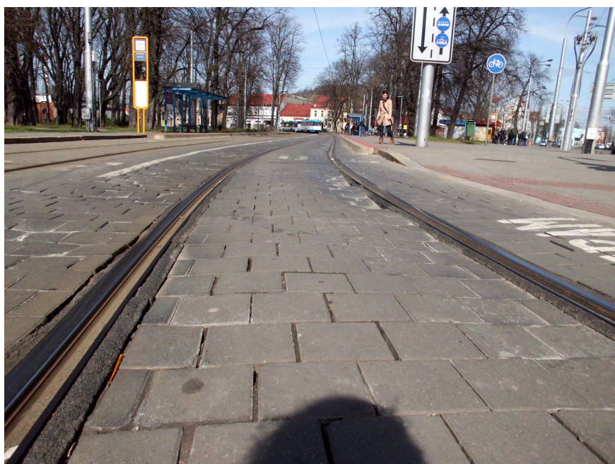
Foto č.4 - Sad Boženy Němcové - Deformace krytu tramvajové tratě.
