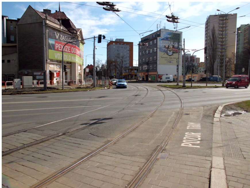
Foto č.3 - Sad Boženy Němcové - Pohled na změnu krytu tramvajové tratě na začátku úseku.
