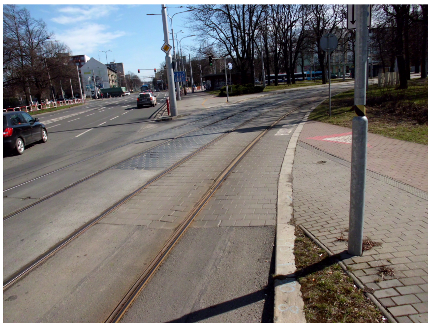
Foto č.10 - Sokolská třída - Pohled na změnu krytu tramvajové tratě na konci úseku.
