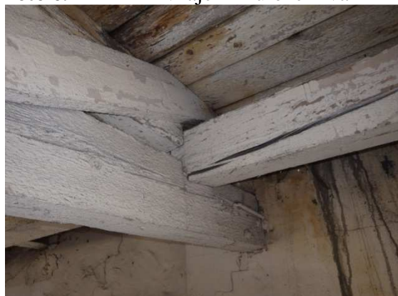
Foto č. 13 – 14 – uložení vazníků a trámů do obvodové zdi,
