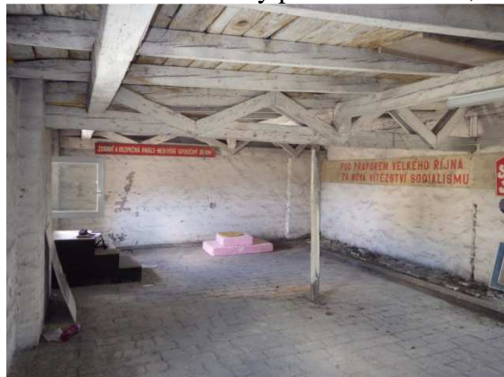
Foto č. 9 – 10 – uložení střešních trámů do obvodové zdi
