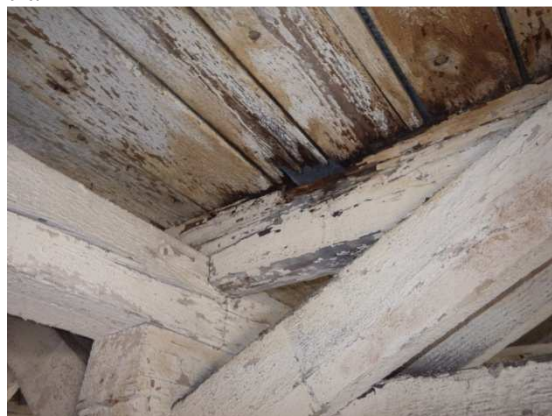
Foto č. 13 – 14 – uložení vazníků a trámů do obvodové zdi,
