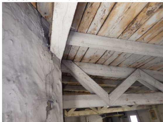
Foto č. 13 – 14 – uložení vazníků a trámů do obvodové zdi,
