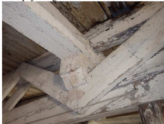
Foto č. 7 – 8 – celkový pohled do krovu, tesařské spoje diagonál
