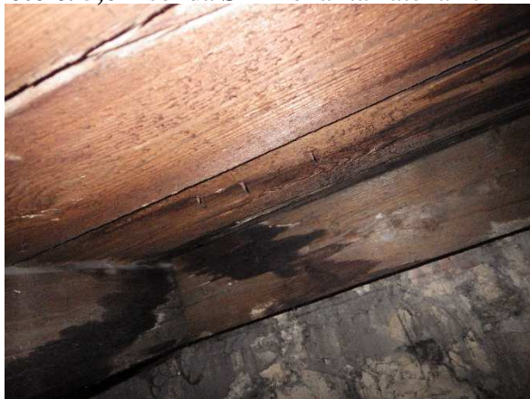
Foto č. 5,6 – sonda ST2-lokalita zatékání.
