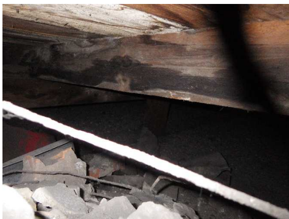
Foto č. 5,6 – sonda ST2-lokalita zatékání.
