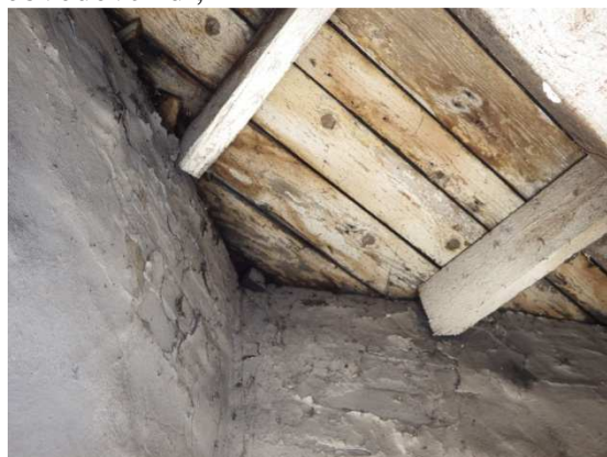
Foto č. 13 – 14 – uložení vazníků a trámů do obvodové zdi,
