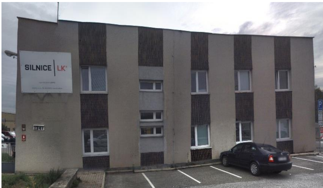
Liberec VI-Rochlice –administrativní budova
