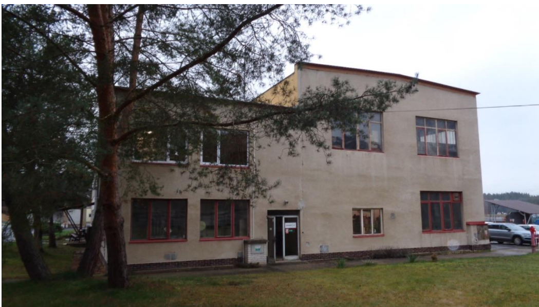
Sosnová-Dílny na opravy vozidel a administrativa
