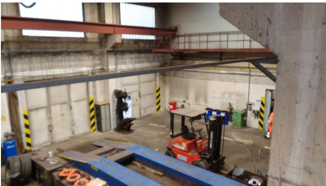
Sosnová -Hala dílen na opravu a údržbu vozidel
