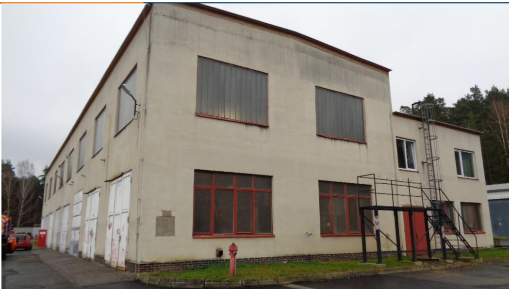
Sosnová-Dílny na opravy vozidel a administrativa
