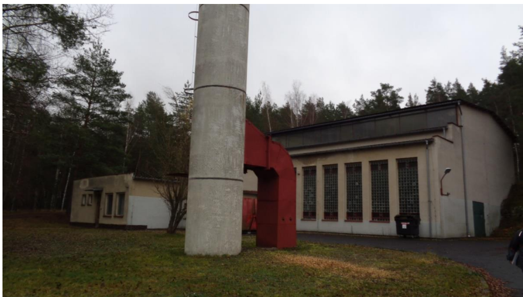
Sosnová-bývalá kotelna s komínem
