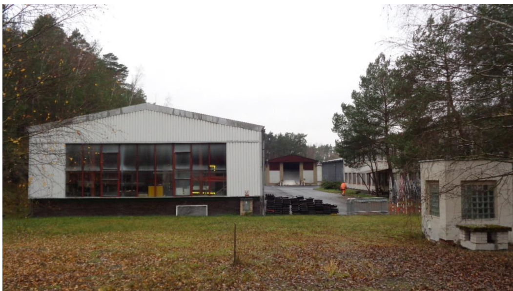
Bílé garáže, vpravo Dílny, uprostřed vzadu sklad posypové soli
