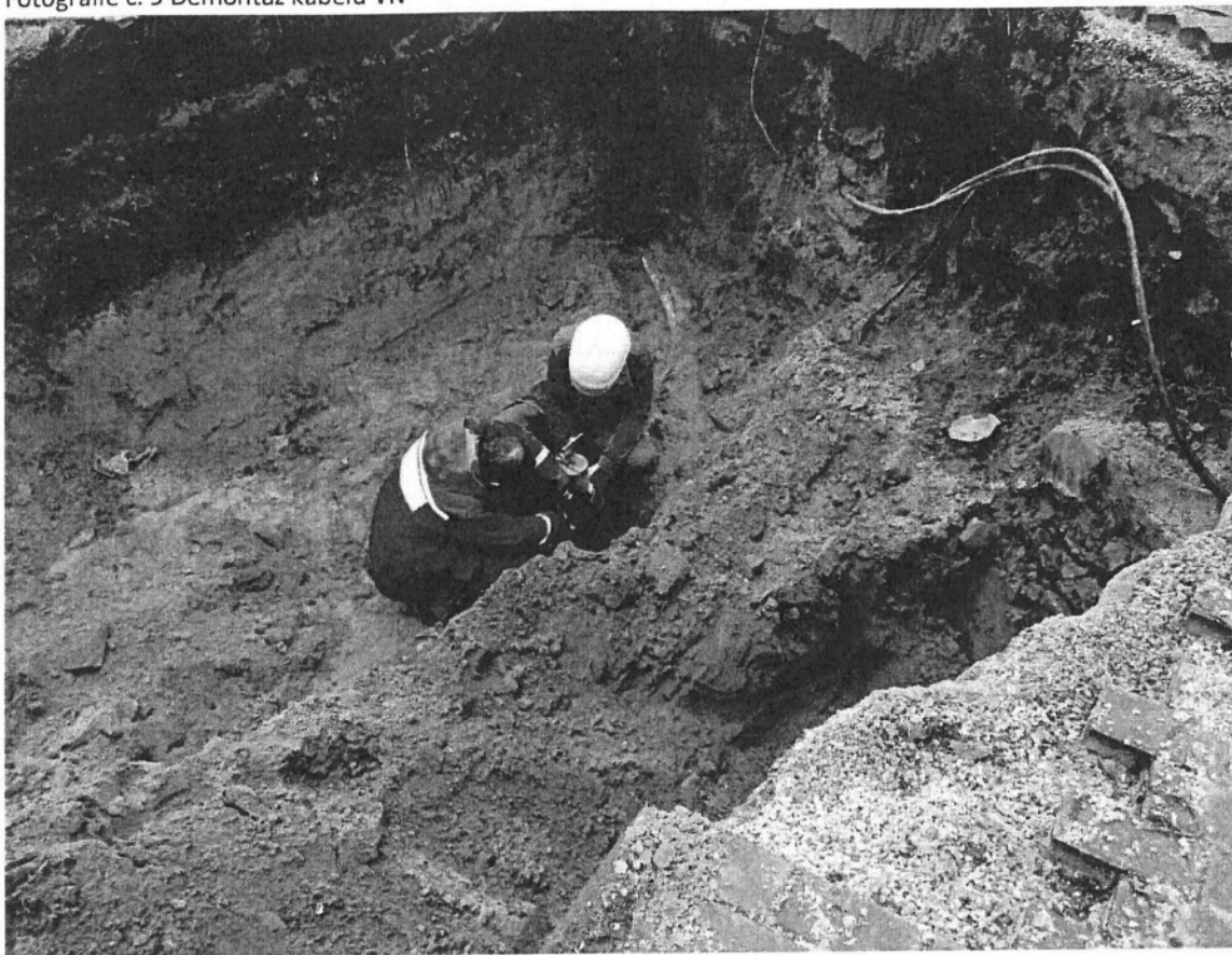
Fotografie č. 9 Demontáž kabelu VN
