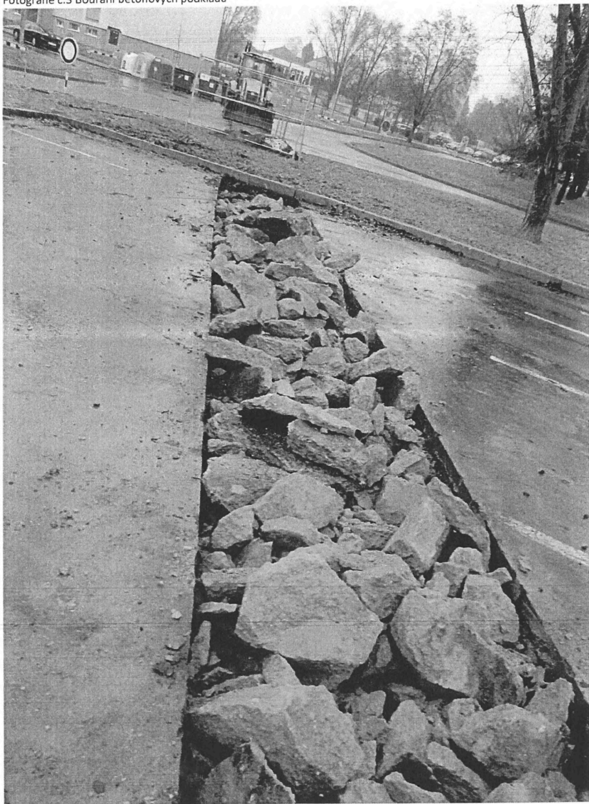
Fotografie č.3 Bourání betonových podkladů
