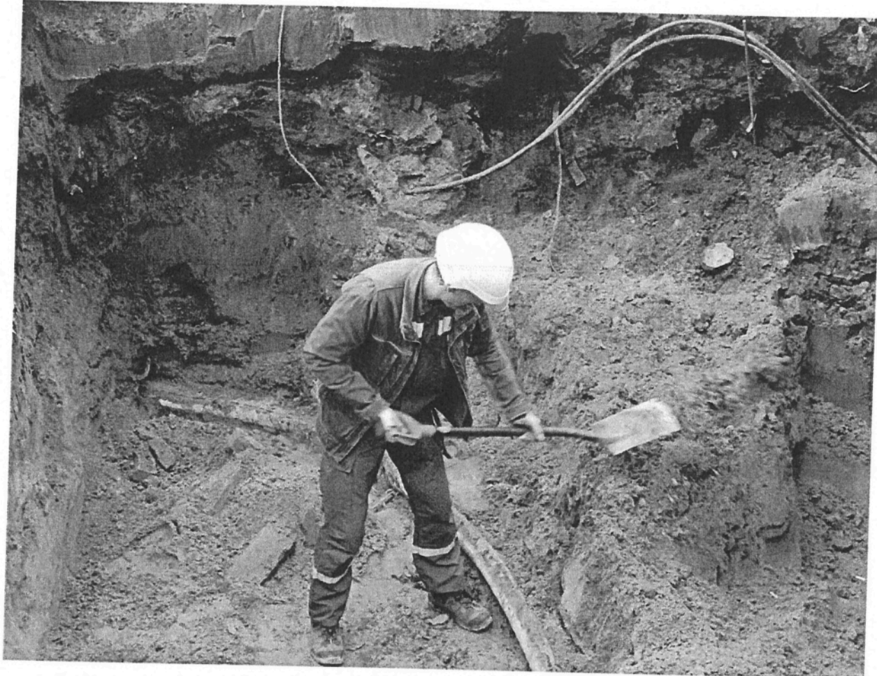
Fotografie č. 8 Demontáž kabelu VN
