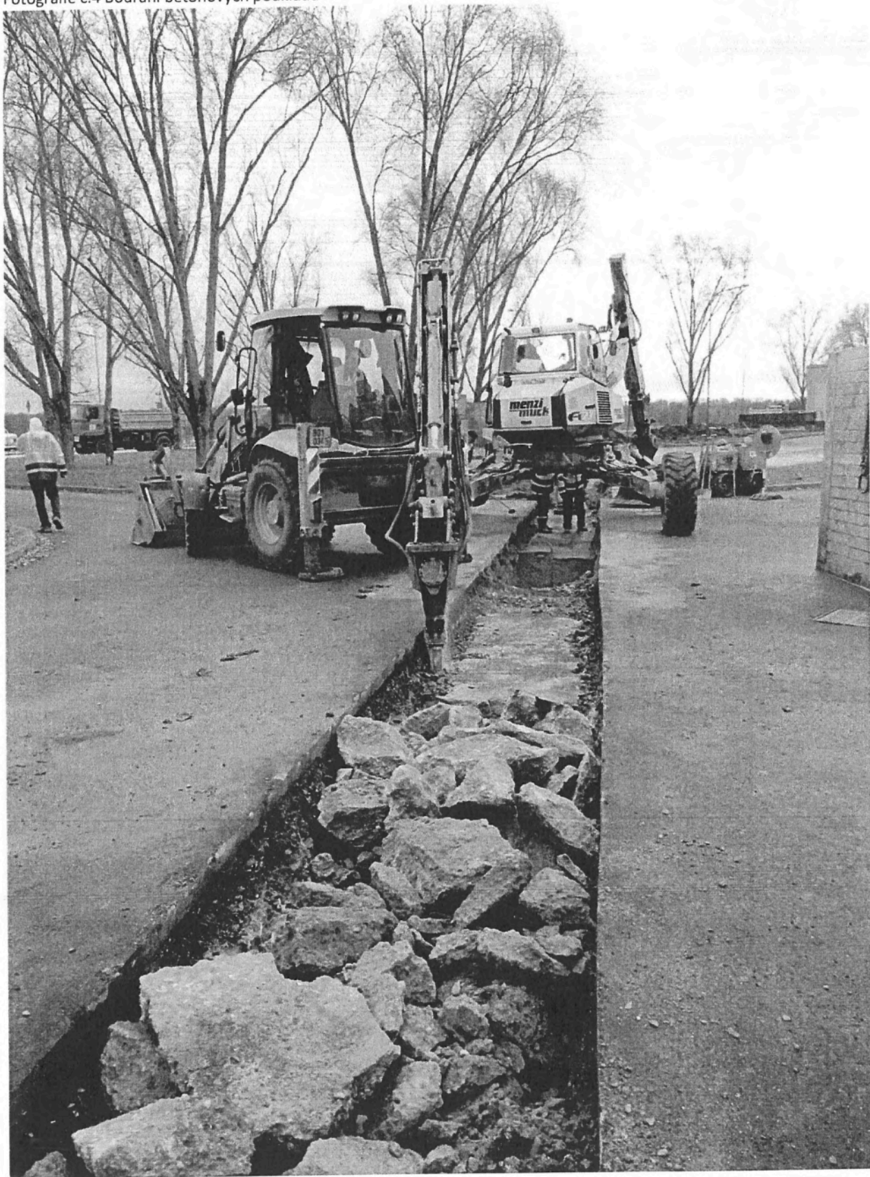
Fotografie č.4 Bourání betonových podkladů
