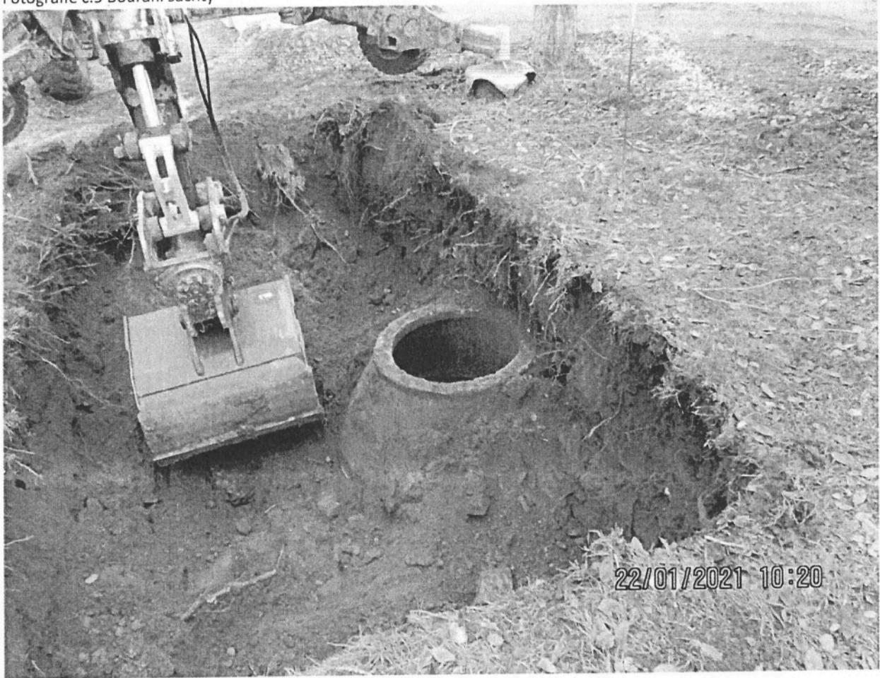
Fotografie č.5 Bourání šachty
