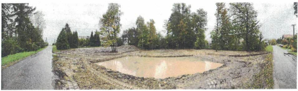
Foto z místa stavby:
