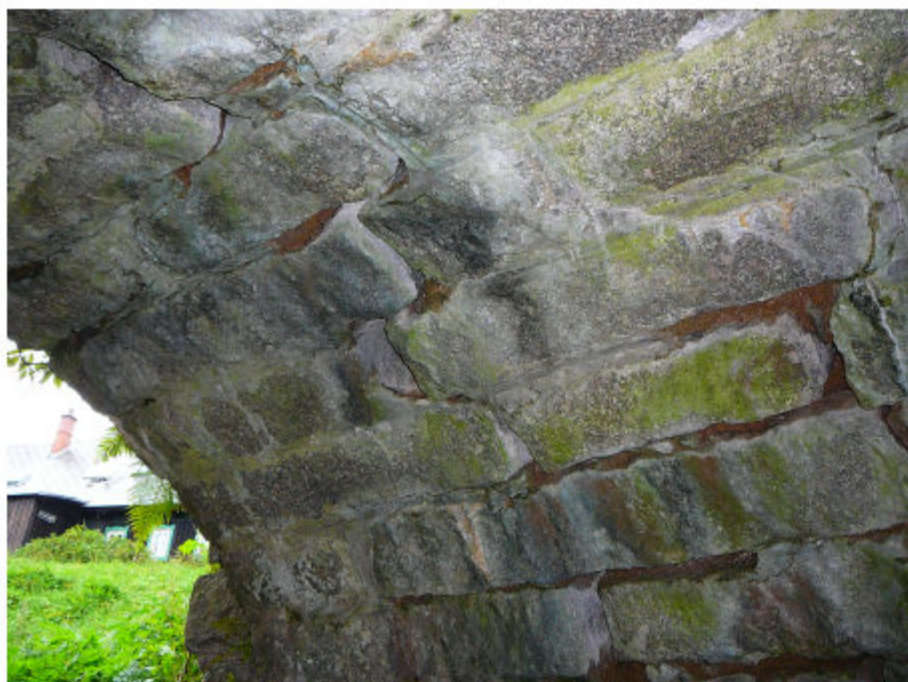
07_TRHLINA V MK NA VTOKOVÉ STRANĚ.JPG
