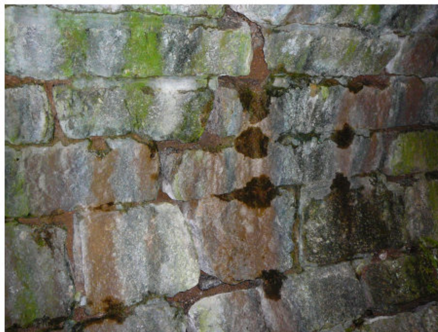
08_ZATĚKÁNÍ A TRHLINY V KLENBĚ.JPG
