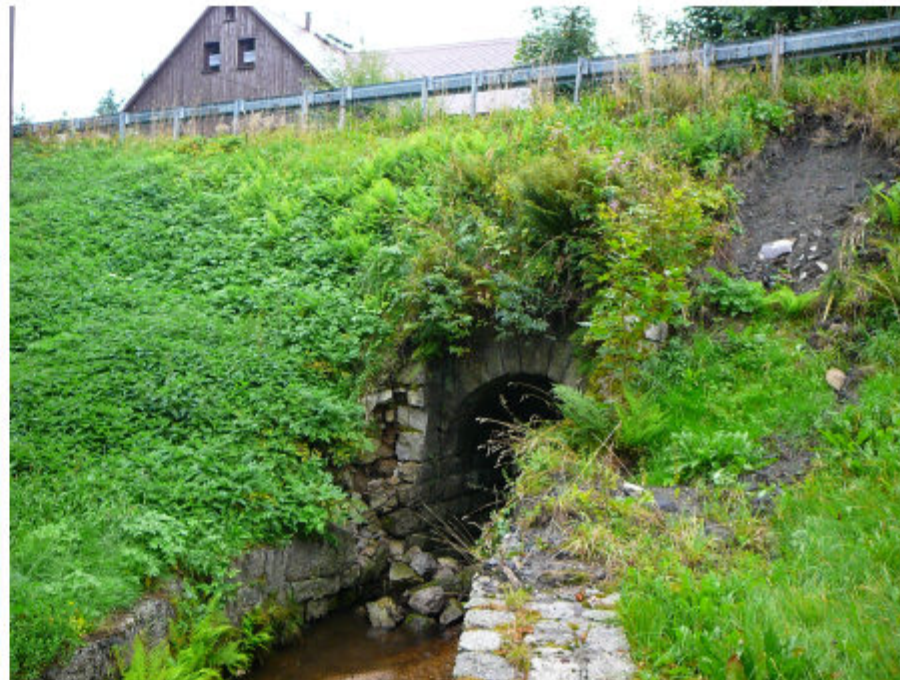
10_SESUV SVAHU NA VTOKU.JPG
