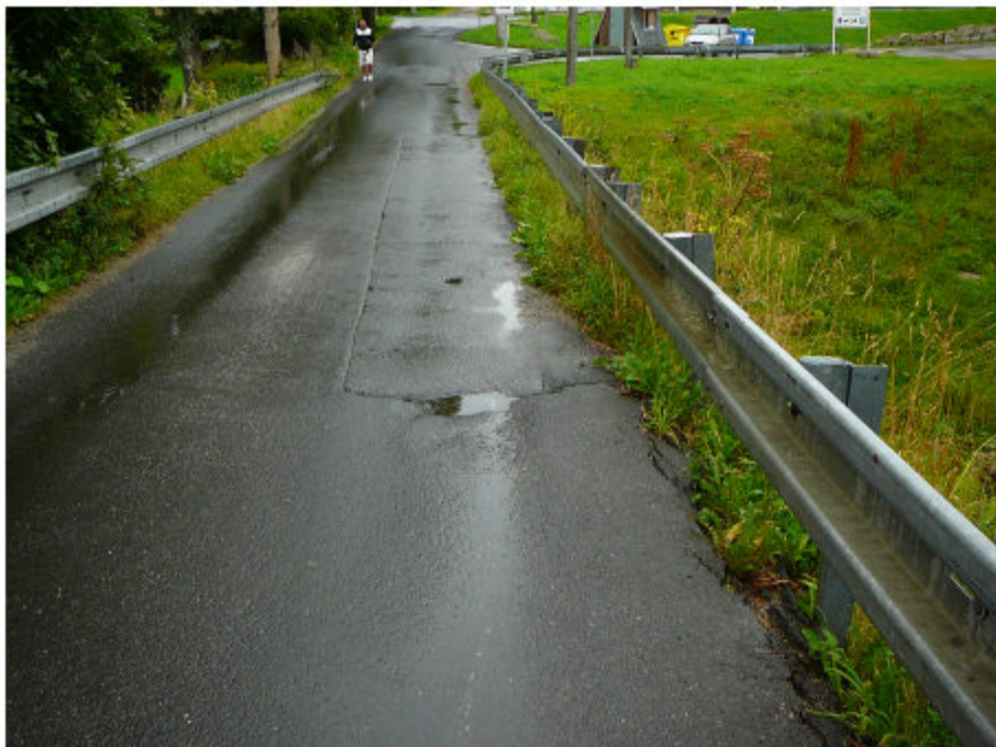
09_TRHLINY VE VOZOVCE NA VTOKOVÉ STRANĚ.JPG
