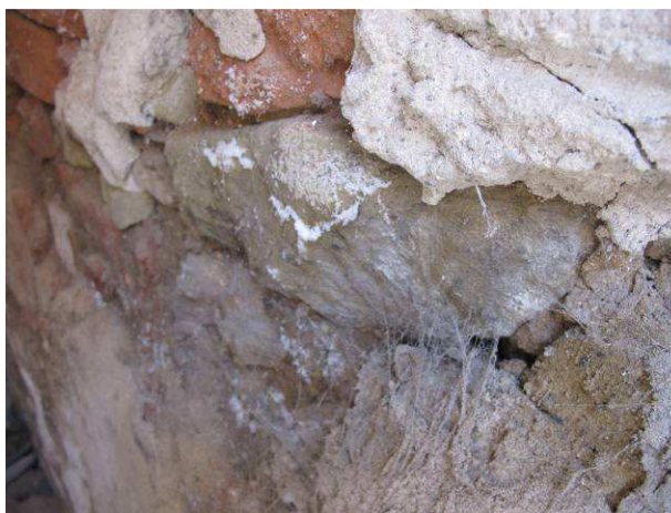
Foto č.12 – viditelné solné výkvěty na povrchu kamene a cihel
