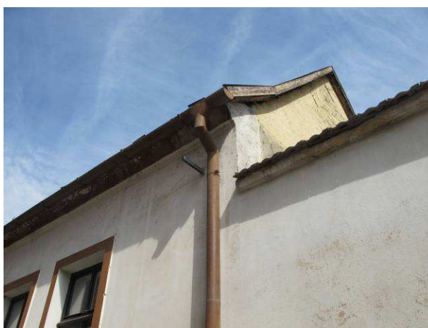
Foto č.10 – viditelné místo vytékání srážkové vody ze střešního žlabu
