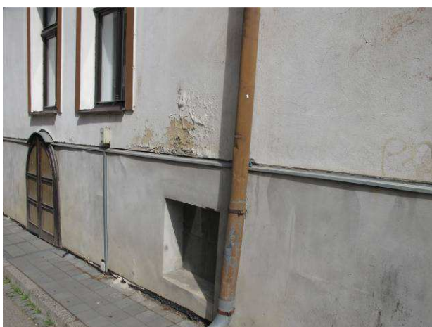
Foto č.9 – degradace omítek nad oplechováním od stékající srážkové vody ze střešního žlabu
