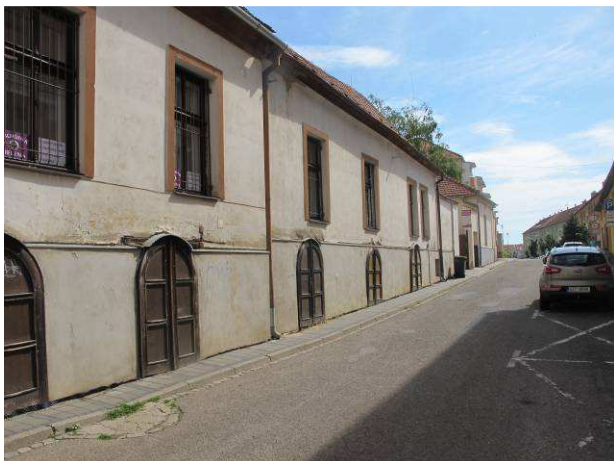
Foto č.7 – degradace omítek nad oplechováním ve vrchní úrovni soklu od odstřikující srážkové vody
