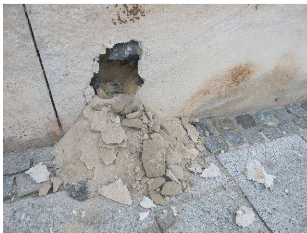
Foto č.2 – jedna z provedených sond přes cementotřískové desky vysypanými omítkami opadanými v dutině mezi obložením a stěnou
