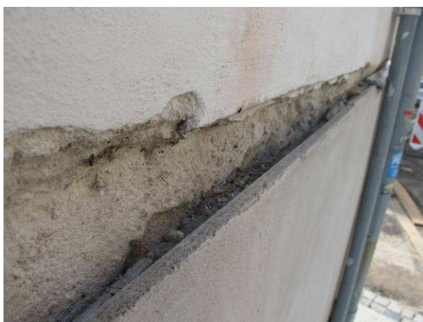
Foto č.6 – chybějící oplechování na ukončení soklové části
