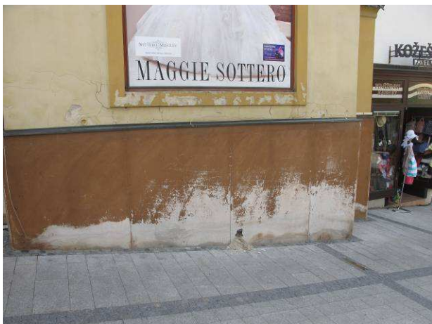
Foto č.1 – cementotřískové obložení soklové části s degradací desek od působení přenesené vlhkosti ze zpevněných ploch a výkvětovných solí
