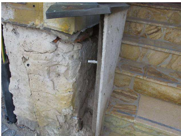
Foto č.3 – odtržená úprava dřevotřískových desek i s nosným roštem od podkladu, viditelná hloubková destrukce jádrových omítek pod obložením
