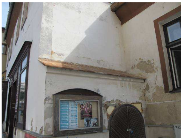
Foto č.4 – poruchy na fasádě objektu od odstřikující srážkové vody u předsazených konstrukcí
