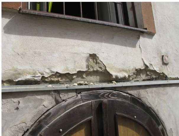
Foto č.8 – detail hloubkové destrukce omítek
