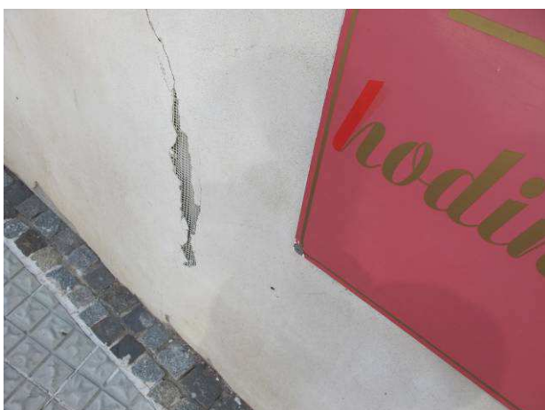
Foto č.5 – odtržená štuková úprava v místě spoje dvou cementopískových desek
