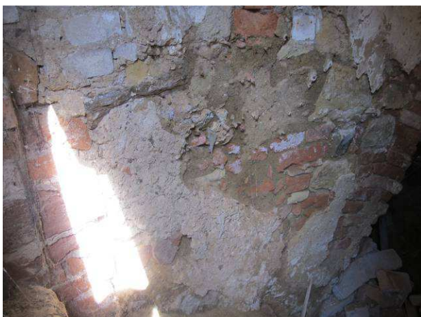
Foto č.11 – hloubková destrukce omítek na ostění obvodové stěny
