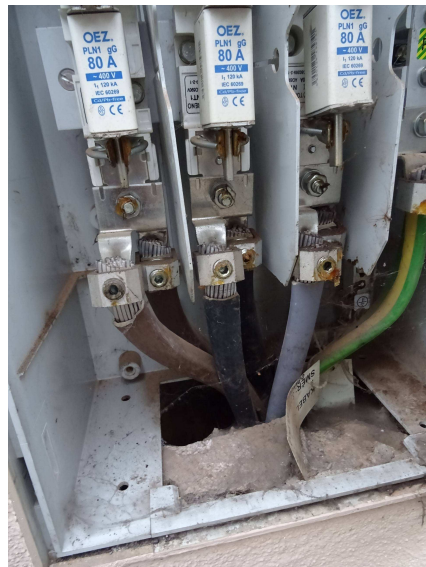
Pohled na přívodní kabely ČEZ a.s., vedené za fasádou.
