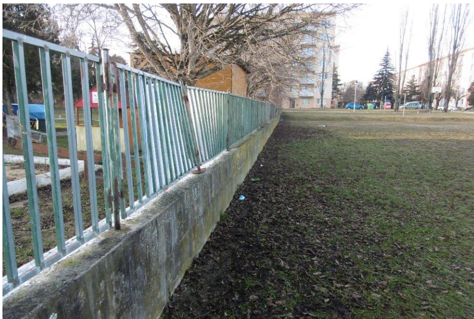
Boční část navrhovaného parkoviště, kde bude nutné opravit zídku a dát nový plot (po odkopání základů bude buď vyspravena nebo vybudována nová, plot bude vyměněn)
