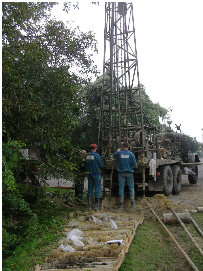
Foto 1 Hloubení vrtu ZN-300 křižovatka ul. U Domoviny a Kunštátská
