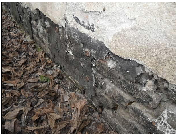
Obr.5 - Poškozená „neexistující“ hydroizolace na zadní straně objektu
