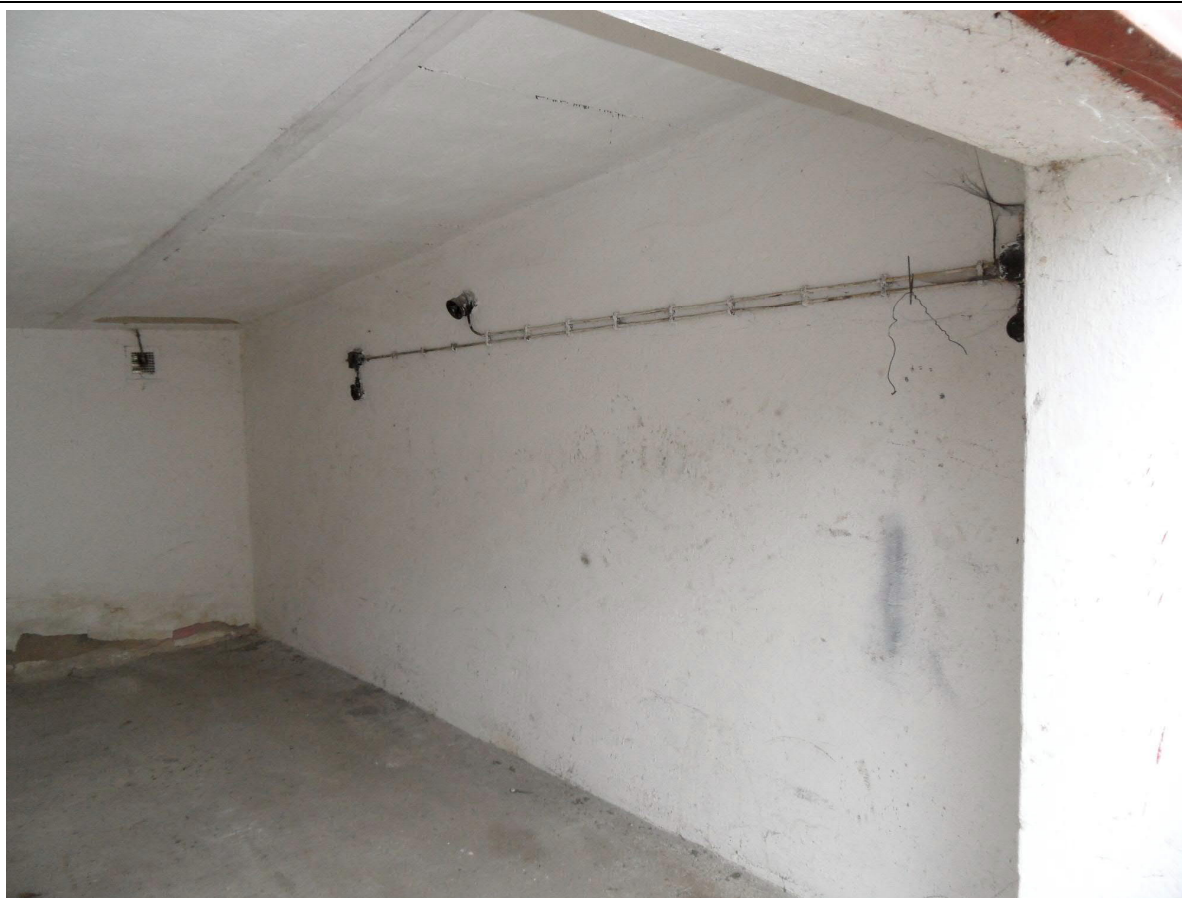
obr.6) Detail vnitřních rozvodů elektrických zařízení (vypínače, zásuvka)
