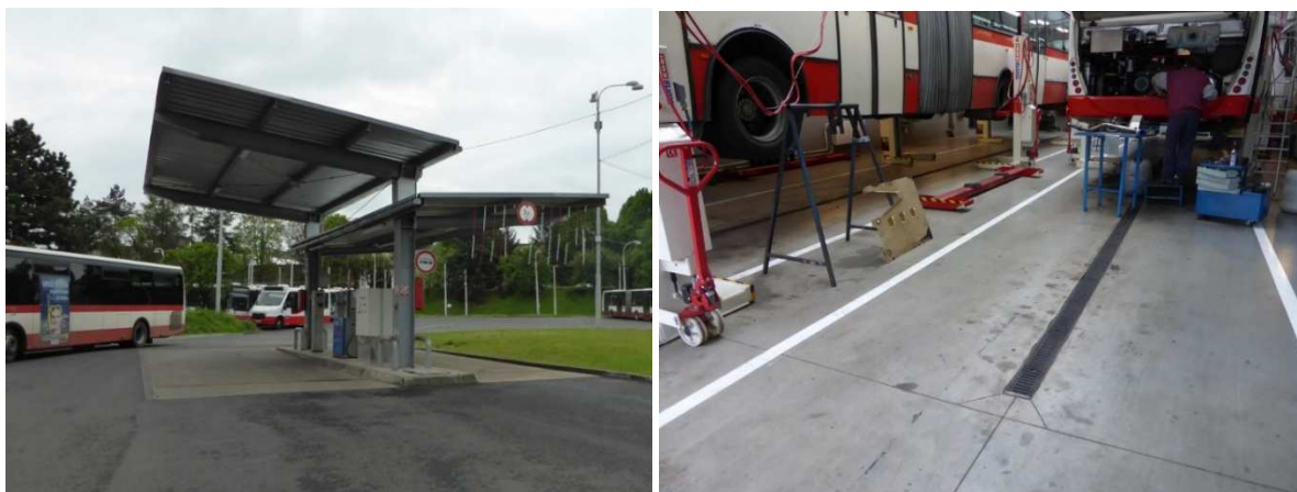
Obrázek 2: ČS nafty, ukázka rekonstrukce podlah servisních hal
