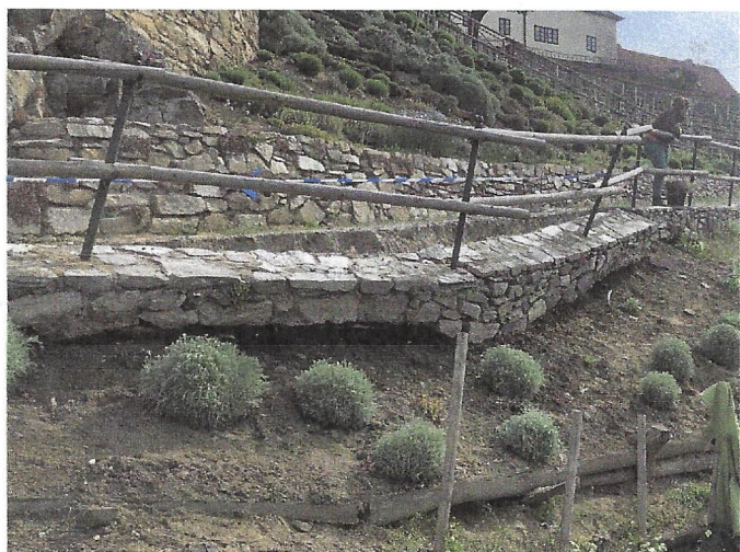
Foto poruchy (výška zdiva 50–75 cm)
