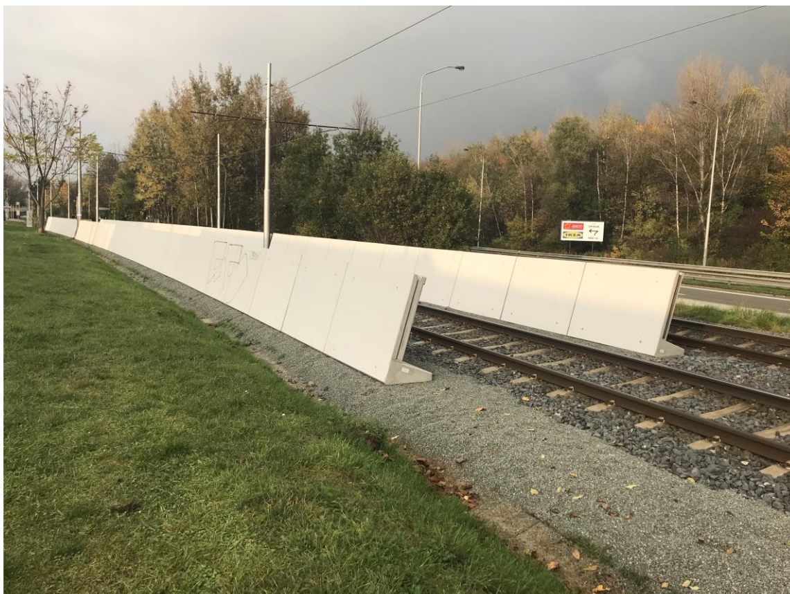
Obr. 1 Aplikace NPC na zkušebním úseku podél ul. Místecká
