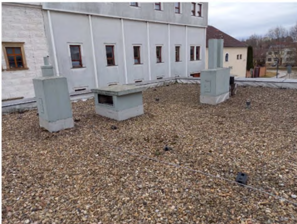
Fotografie 1 – Pohled na řešenou střechu.
