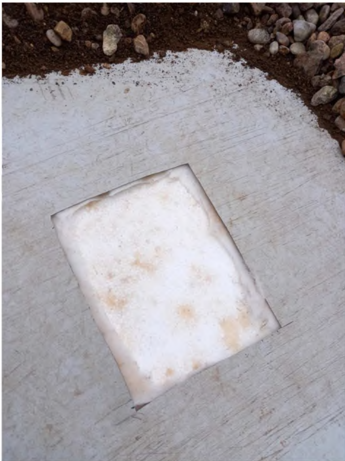
Fotografie 5 – Absolutně vlhký polystyren v místě sondy.
