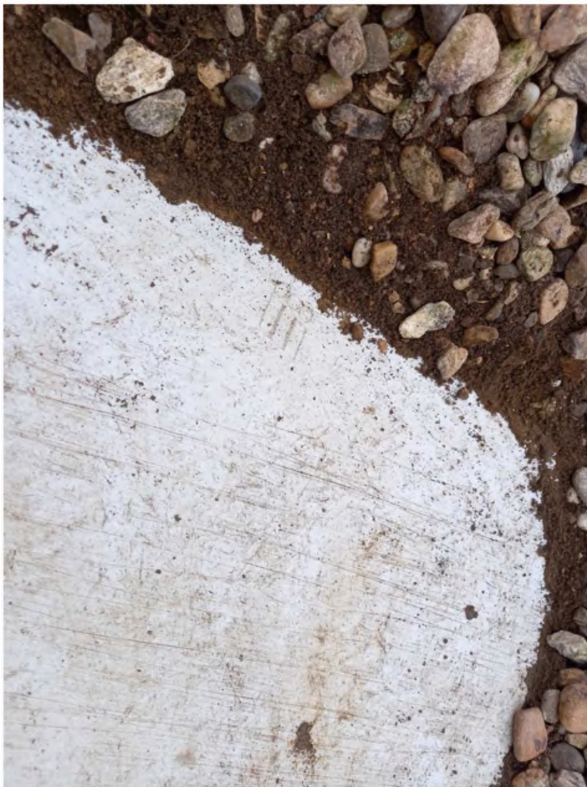
Fotografie 3 – Očištěné místo sondy, značná vrstva zeminy ve stabilizačním materiálu.
