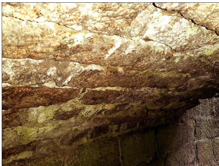
213-20191008_143523.jpg Zatékání, vypadané spárování
