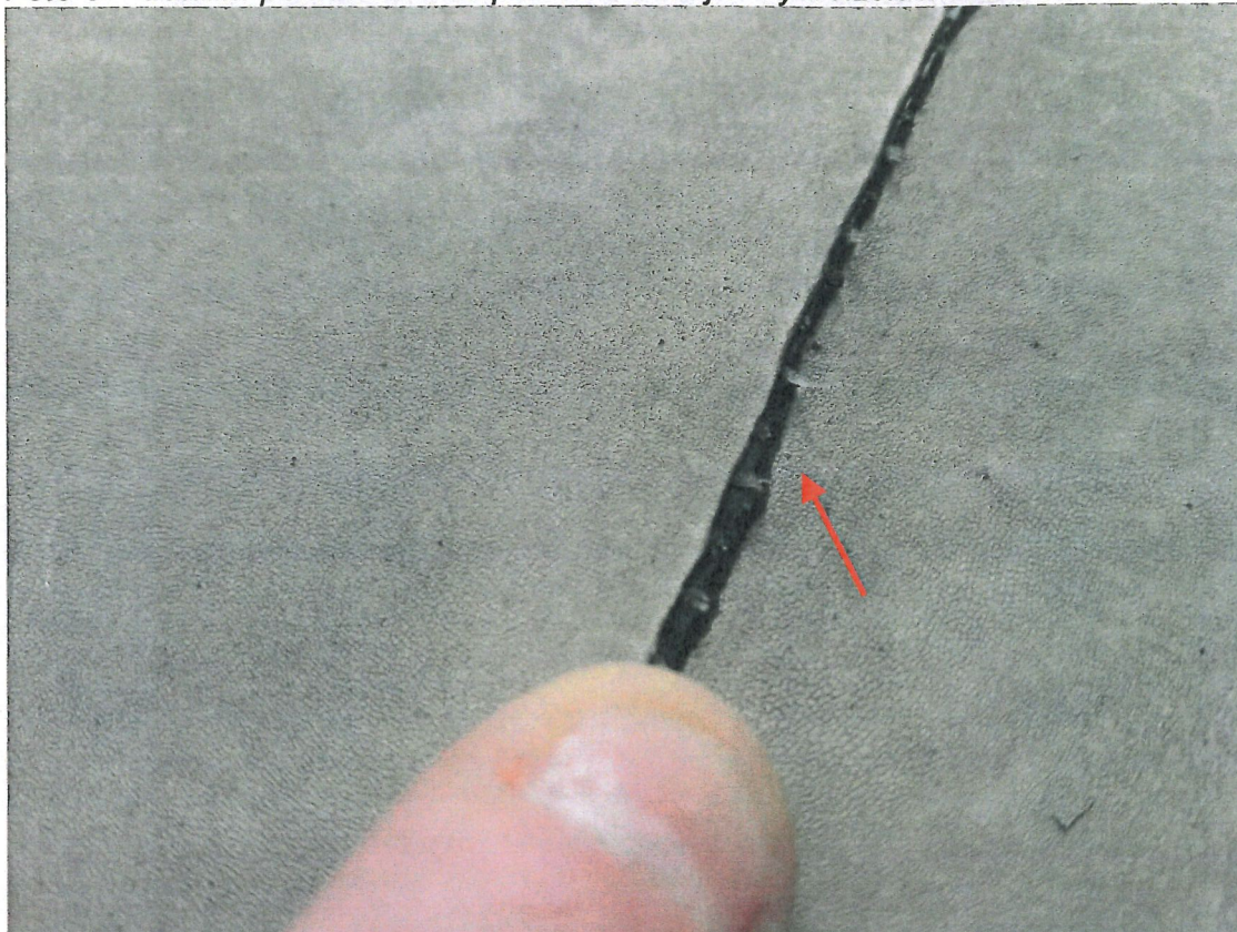
Foto 5 – detailní pohled na stav povrchu stávající hydroizolační fólie
