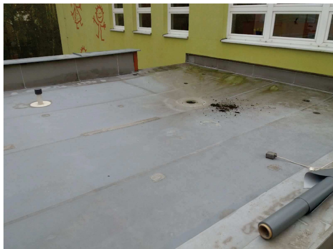
foto/6/ Pohled na střeche E
