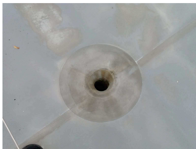
foto/47/ Pohled na vtok u střechy B
