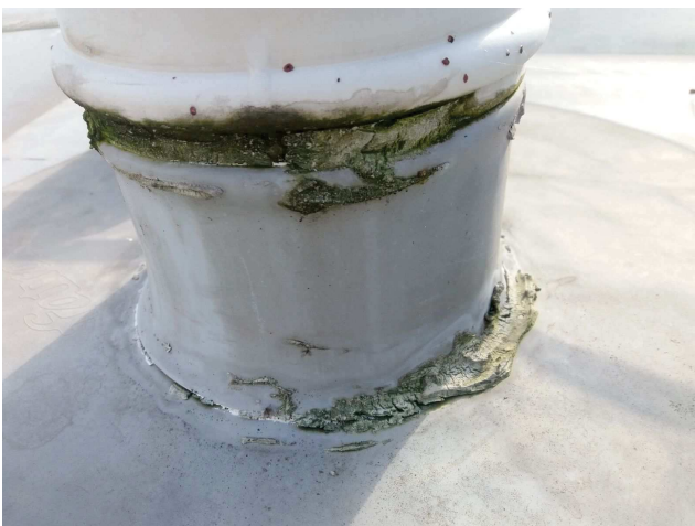
foto/42/ Pohled na provedení spoje pomocí tmele
