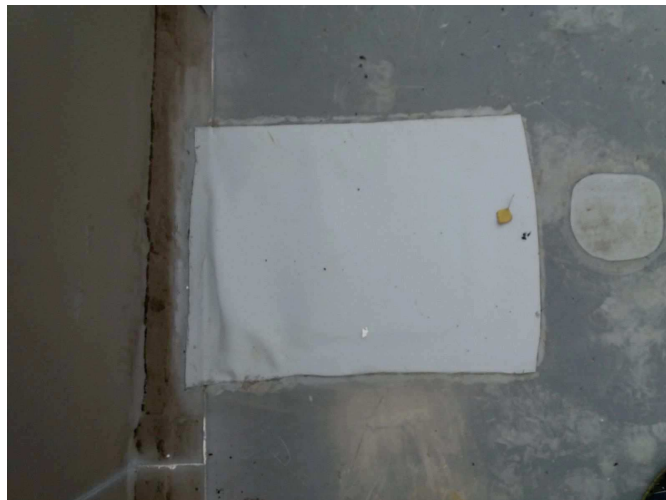
foto/12/ Pohled na zapravenou sondu S3
