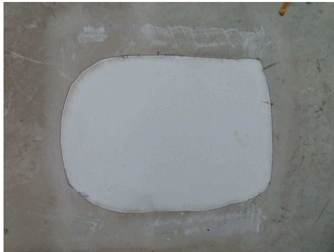
foto/8/ Pohled na zapravenou sondu S1
