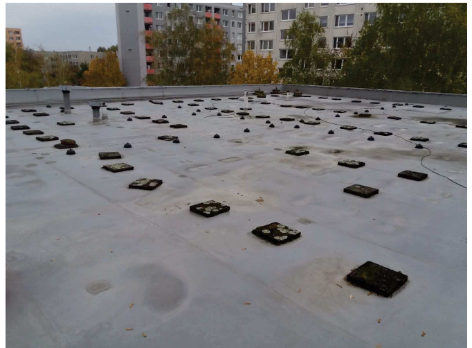
foto/2/ Pohled na střechu B
