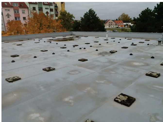
foto/3/ Pohled na střeche C
