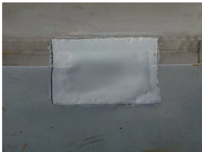
foto/20/ Pohled na zapravenou sondu S7
