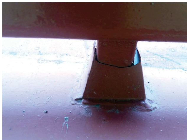
foto/41/ Pohled na oplechování v místě kotvení zábradlí u střechy E
