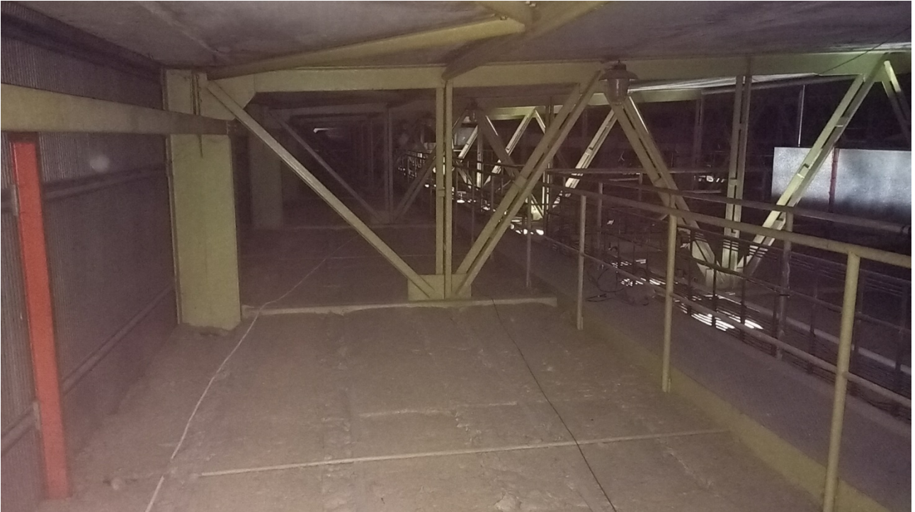
Příloha č. 1 – fotodokumentace stávajícího střešního meziprostoru se střešními vazníky sportovní haly
