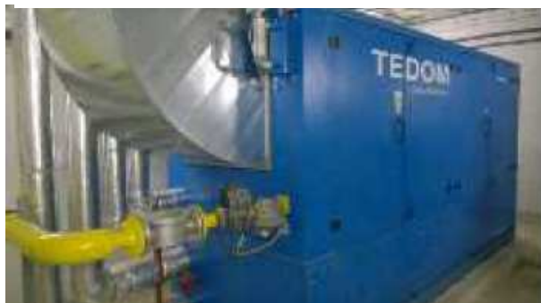
Obrázek 10 a 11: Kogenerační jednotka a trafostanice
