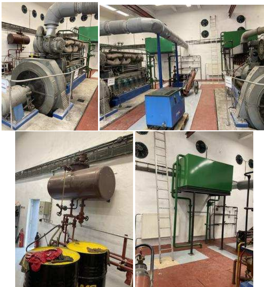
Obrázek 4, 5, 6 a 7 - dieselagregát po generální opravě
