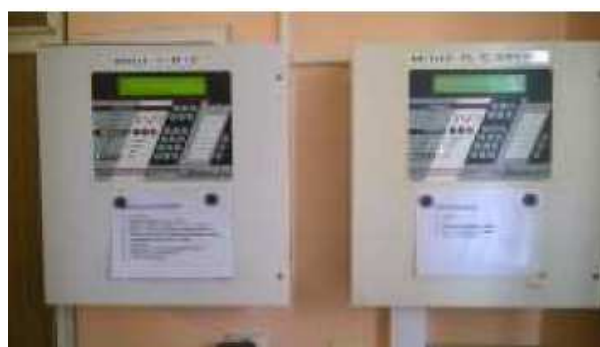
Obrázek 1 a 2: Ústředny EPS
