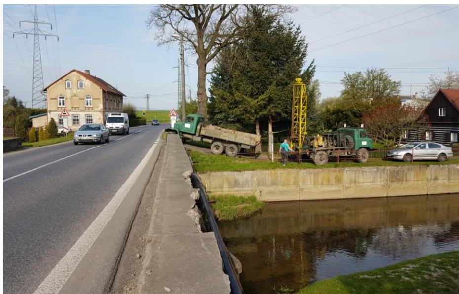
Osazování adjustáž vrtné soupravy pro vrt V1 na západním břehu Svitávky
