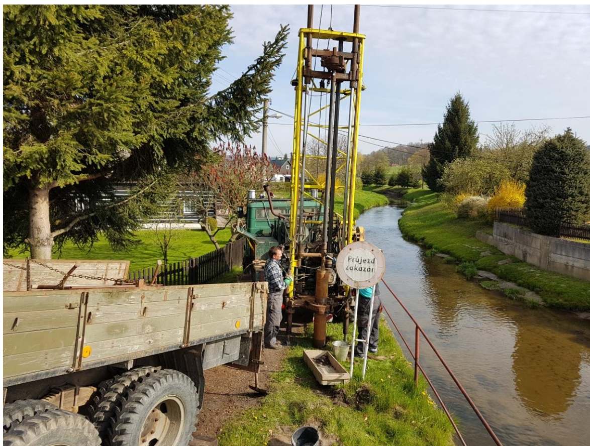
Vrtná souprava při hloubení sondy VI
