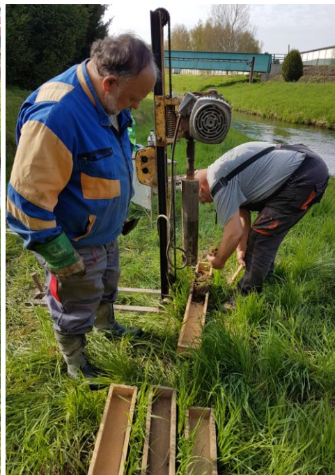
Fotodokumentace výnosu – vrtného jádra ze sondy V2. Umísťování a provoz vrtné soupravy pro hloubení vrtu V2
