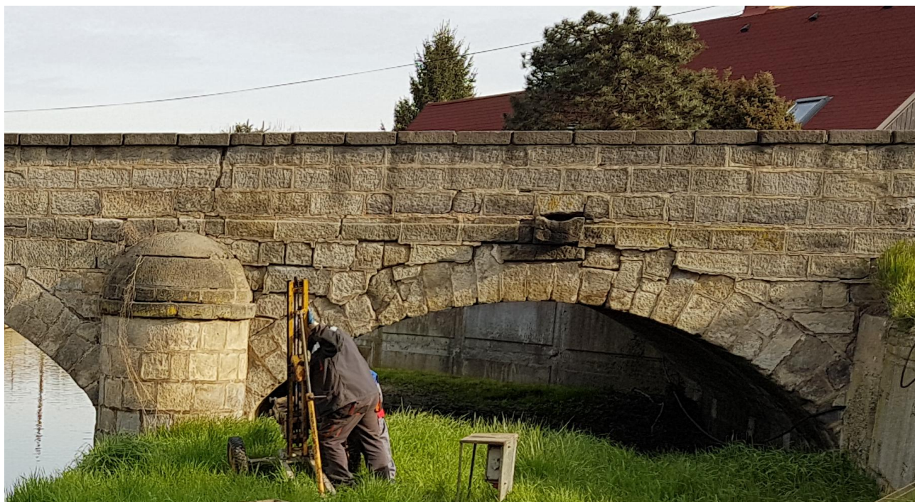
Konstrukční zdivo kleneb jeví zřejmé známky recentních deformací
