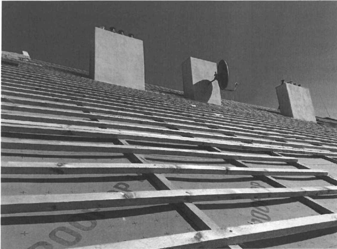
Opravené nadstřešní části komínových těles
