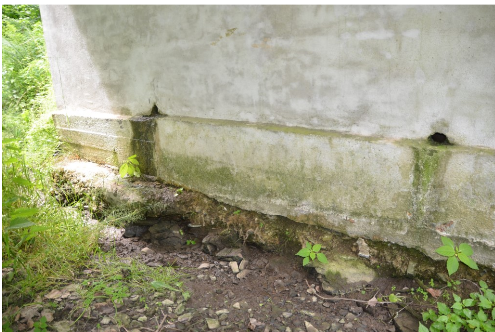
Obr.G44-16 Detail paty druhé podpěry, pravobřežní opěry. Pohled zprava doleva (po vodě) a ve směru staničení, - základový ústupek v patě opěry (která je dle dostupných podkladů založena na pilotách) je při velkých průtocích podemílán, - při běžné hladině není opěra vodou omývána.
