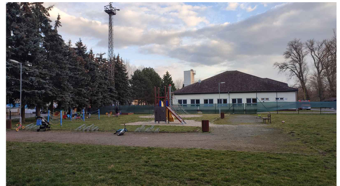
Novostavba hasičské zbrojnice JSDH Kyjov se zázemím hasičského sportu včetně víceúčelového hřiště FOTODOKUMENTACE
