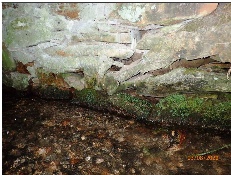
Detail rozvolněného zdiva v lici O1 u L boku mostu.
