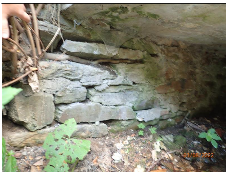
Detail rozvolněného zdiva O1 u P boku mostu.
