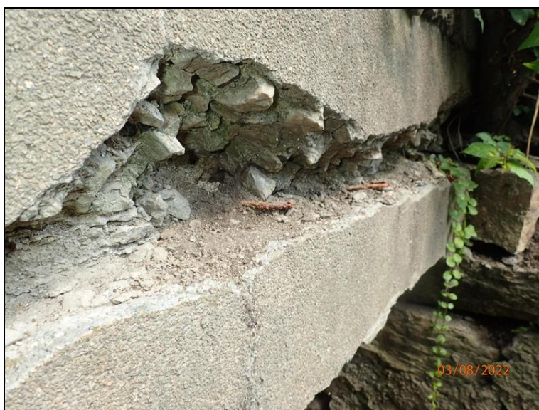
P bok mostu, hluboký mrazový rozpad betonu v horizontálním pruhu, nejspíše podél prosakující pracovní spáry.
