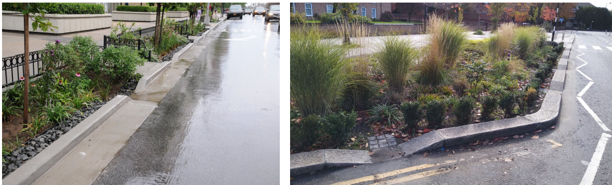
Obr. 5-6: Příklady snížení obrubníků
