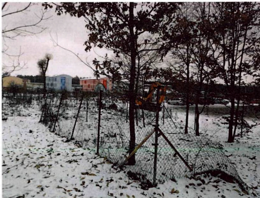
D - Odstranění pozůstatků oplocení
