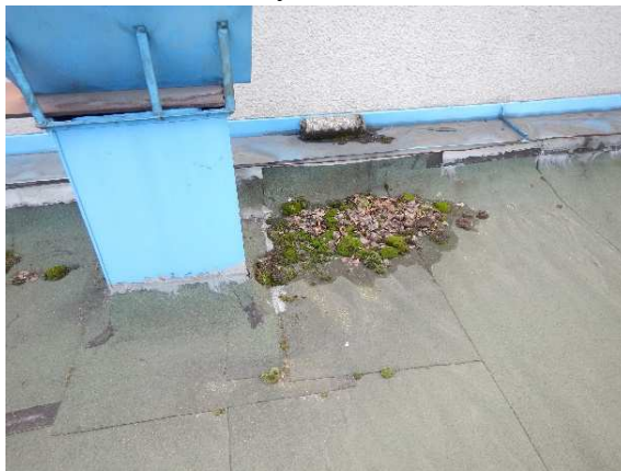
Foto č. 31-32 - exteriér- růst mechu; spadlé listí na střeše u sondy ST2
