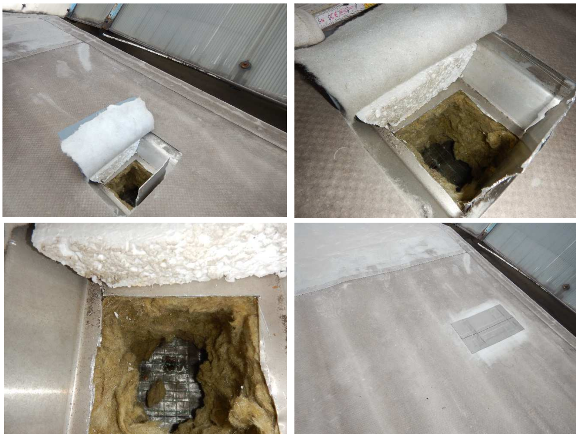
Foto č. 21-24 - sonda ST4 - pohled na sondu ,detail rozvrstvení;
