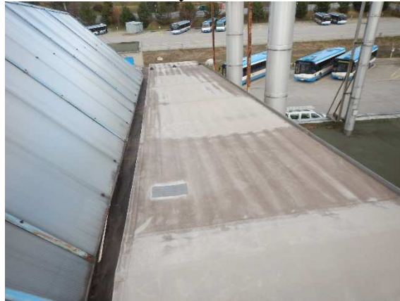
Foto č. 31-32 - exteriér- růst mechu; spadlé listí na střeše u sondy ST2
