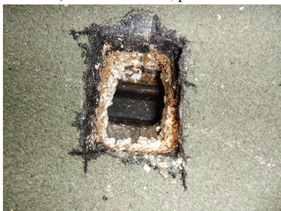
Foto č. 13;14 - sonda ST2-, zapravení sondy- umístění, detail;;
