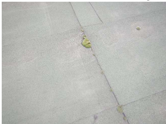
Foto č. 31-32 - exteriér- růst mechu; spadlé listí na střeše u sondy ST2
