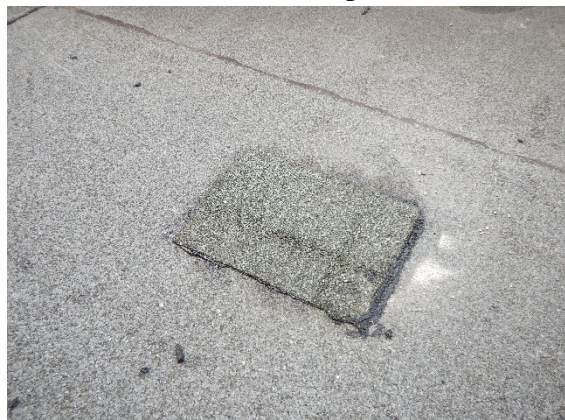
Foto č. 15;16 - exteriér- zapravení sond ST1 a ST2;
