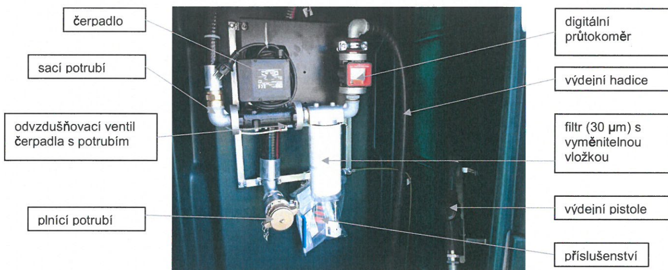
(pohled po otevření krytu výdejního zařízení s objemem 5000 a 9000 l s digitálním průtokoměrem)
