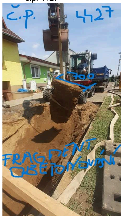
Vybourané stávající potrubí s obetonováním
