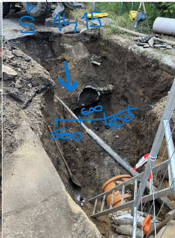
betonové sedlo stávající ŽB potrubí
