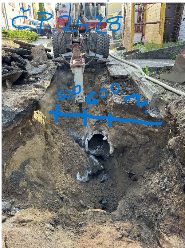
Beton na stávajícím potrubí Š1418 – Š1419
