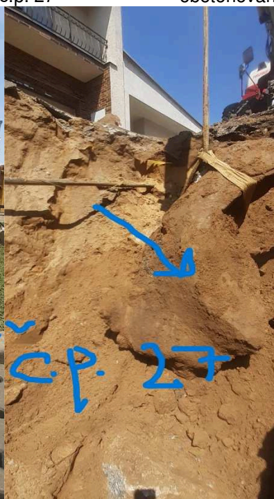
Vybourané stávající potrubí s obetonováním
