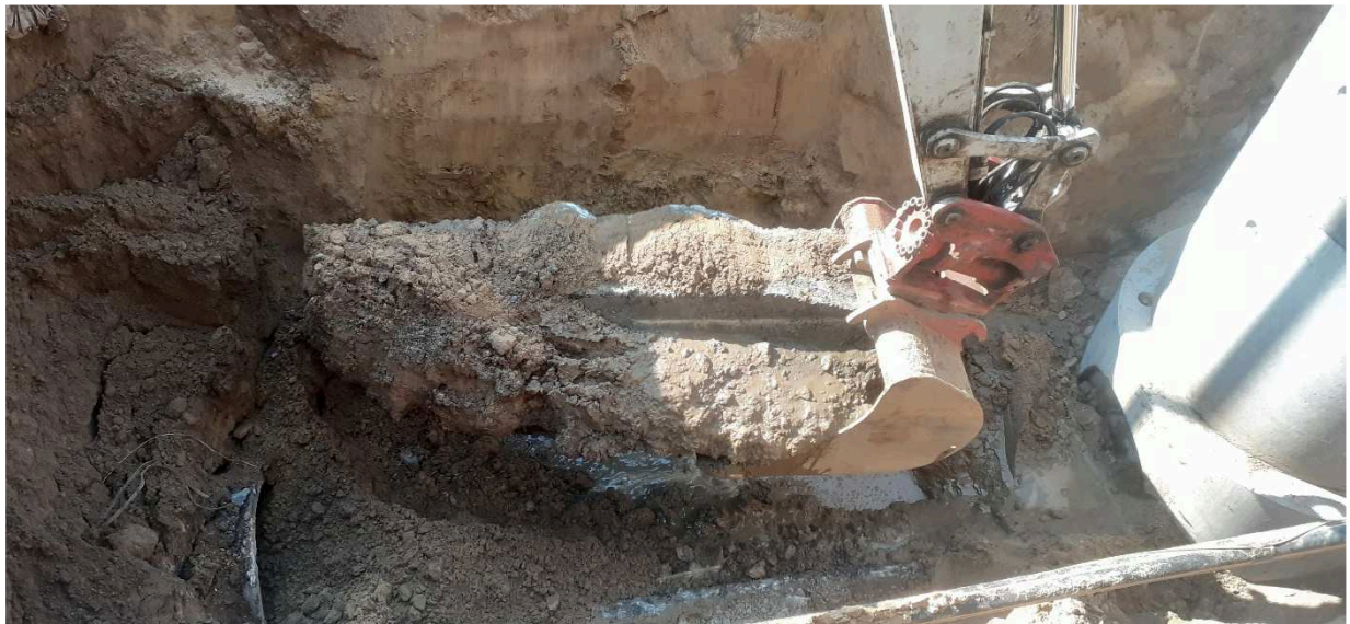
Obetonování stávajícího potrubí
