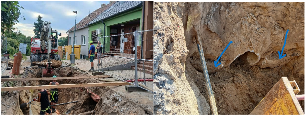
Beton na stávajícím potrubí
