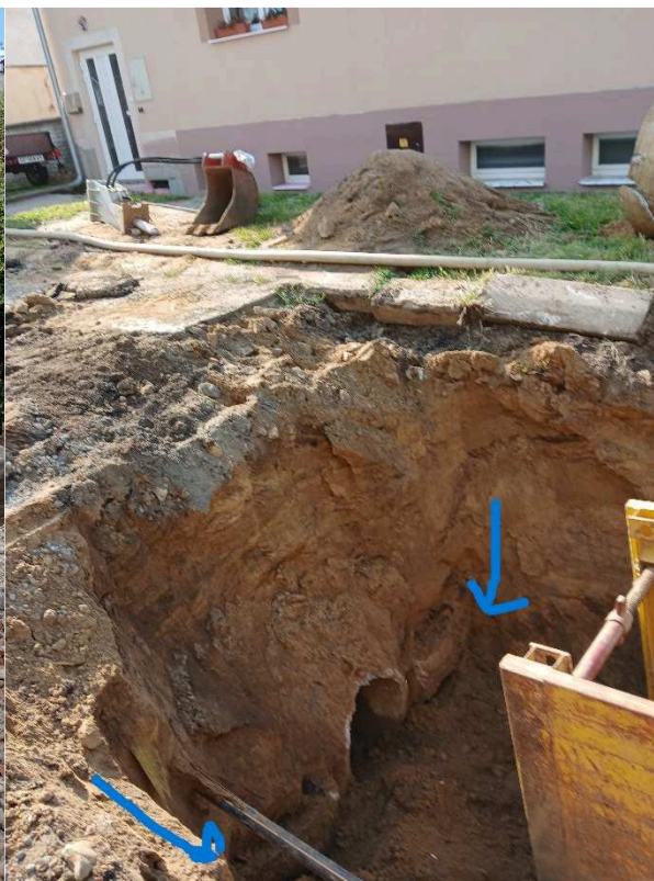
obetonování potrubí Š1415
