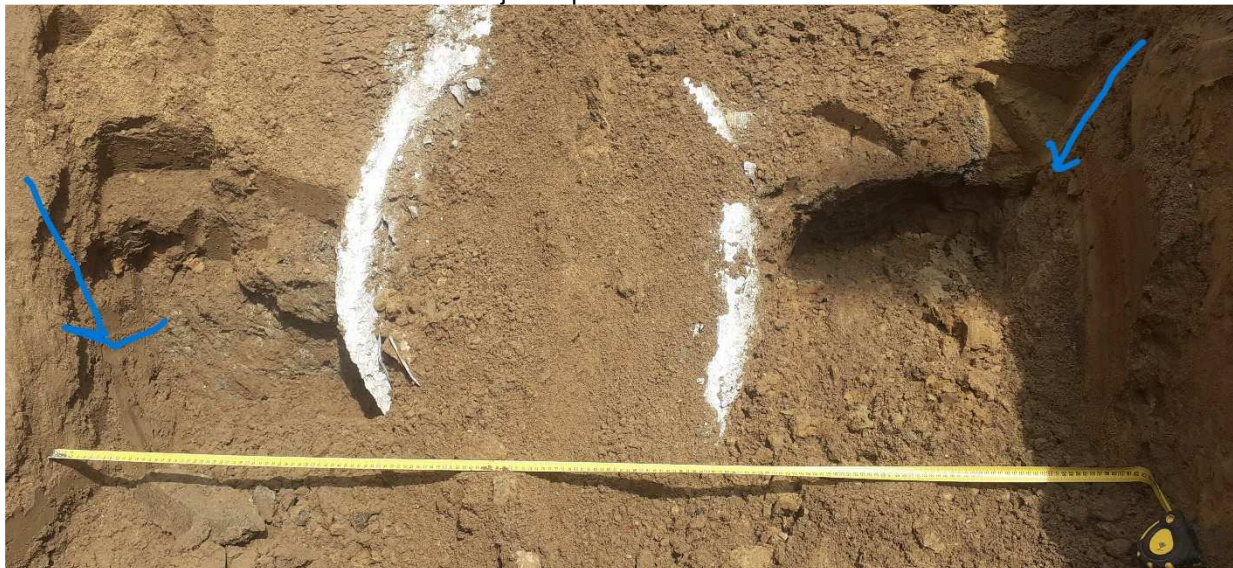
Obetonování č.p. 3612, č.p. 3897, č.p. 3332
