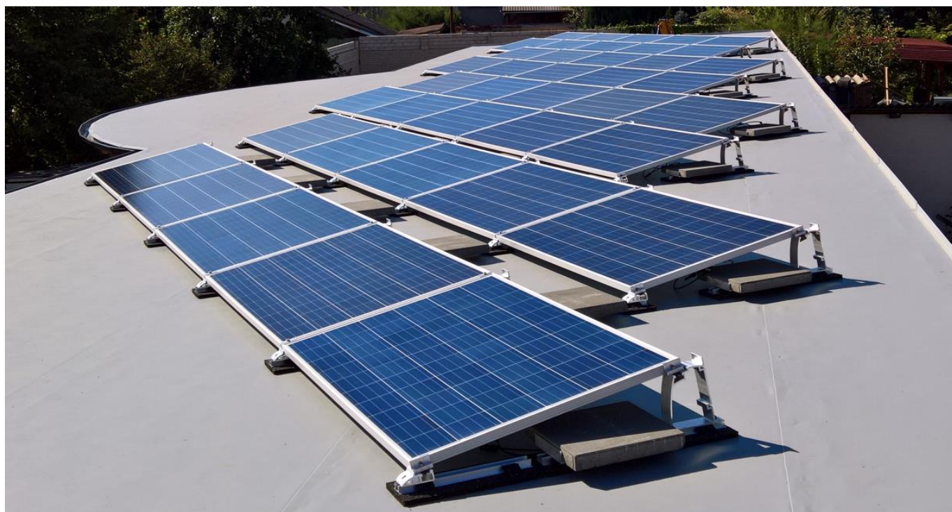
Ilustrační obrázek uložení panelů na rovné střeše, panely ve sklonu 10°.
