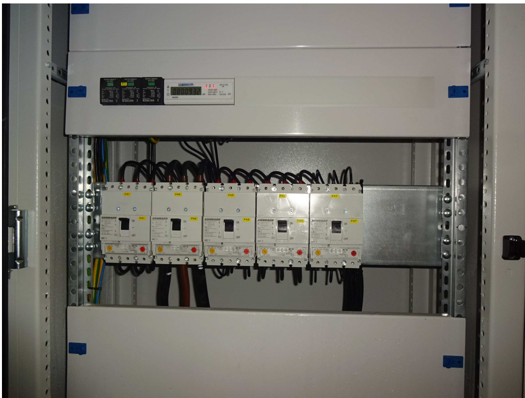
volný prostor pro osazení jističe FA8 navrhovaného vzt. zařízení
