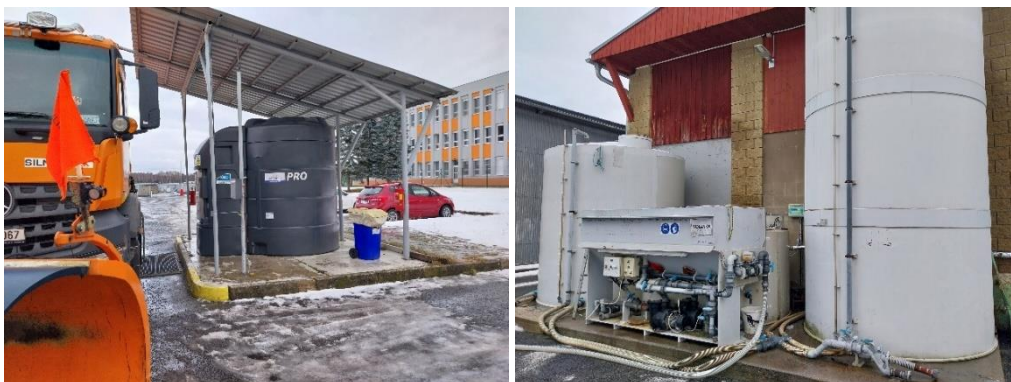
Foto č. 9 a 10 – venkovní čerpací stanice (nadzemní nádrž nafty) a technologie solanky
