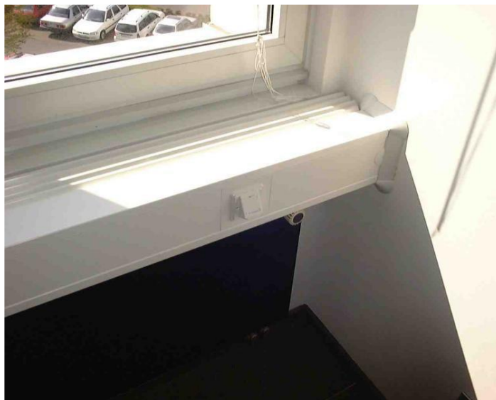
Obrázek 23 příklad upevnění podokenního kabelového kanálu před topným tělesem
