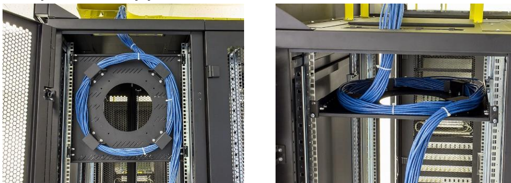
Obrázek 7 příklady drážky vyvazování rezerv kabelu ve stojanu
