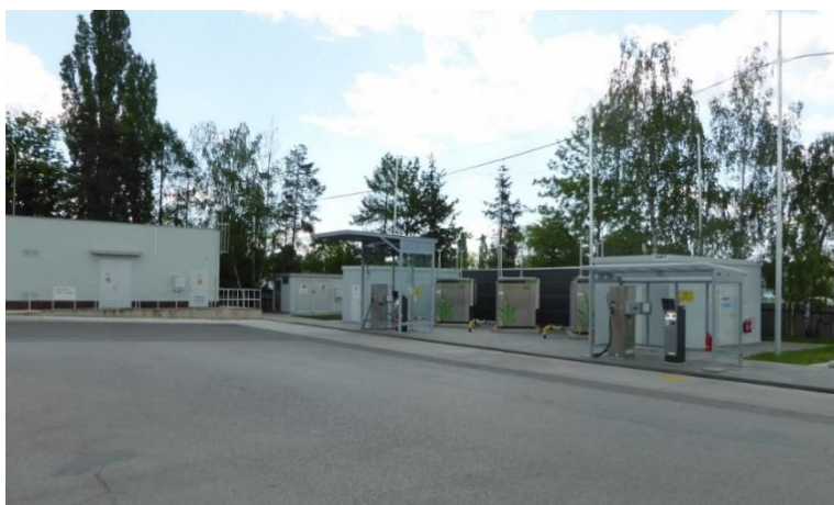
Obrázek 9: Čerpací stanice CNG
