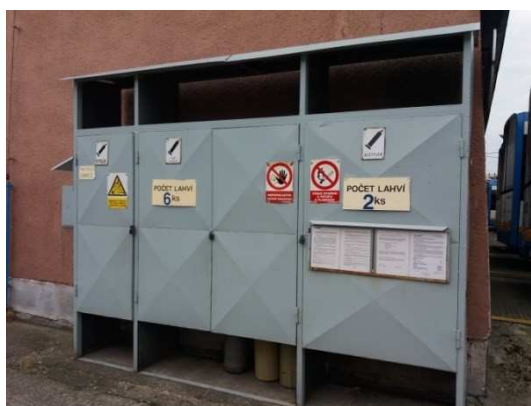
Obrázek č. 21 Sklad tlakových lahví.
