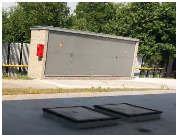
Obrázek č. 18 Hlavní uzávěr plynu.
