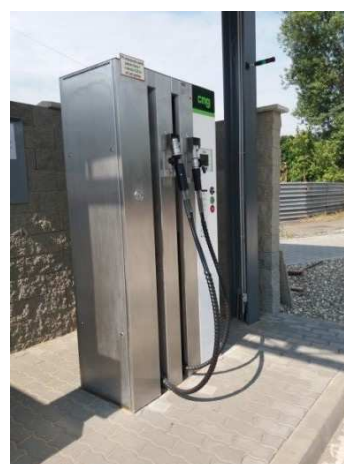
Obrázek č. 12 Výdejní stojan CNG.
