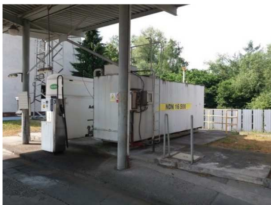
Obrázek č. 13 Nadzemní nádrže na AdBlue a Naftu.
