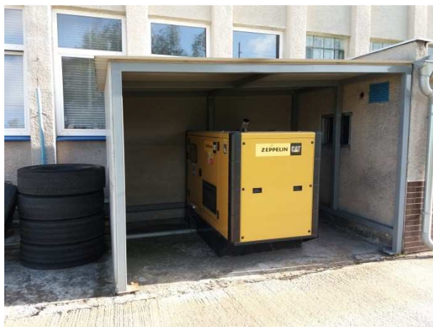
Obrázek č. 20 Diesel agregát.
