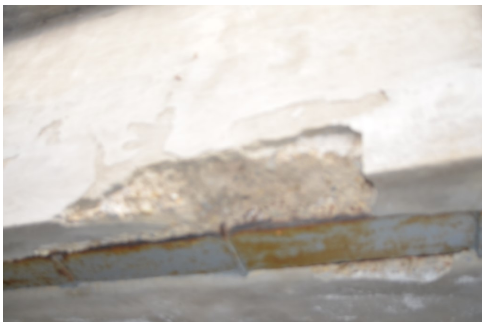
Obr.G42-19 Detail poruchy betonu nosné konstrukce na její levé podhledové hraně před lícem druhé podpěry, plzeňské opěry. Pohled zleva doprava a vzhůru.
