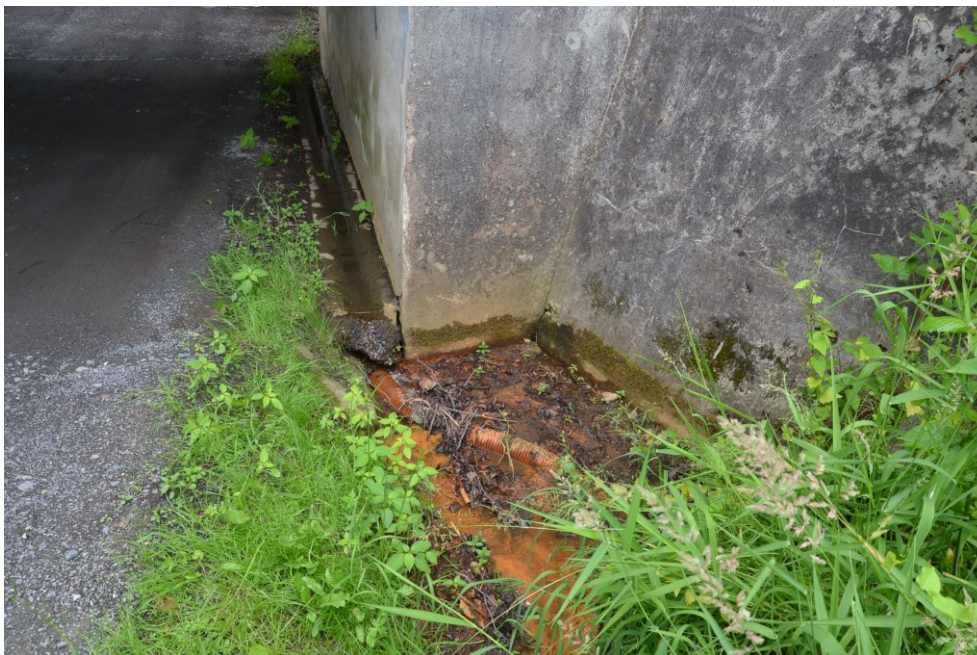
Obr.G41-23 Špatně odvodnitelný prostor na výtoku z odvodňovacího žlabu vedeného při patě pravého křídla 2. podpěry, plzeňské opěry a dále při patě samotné opěry. Pohled zprava doleva a dolů,
