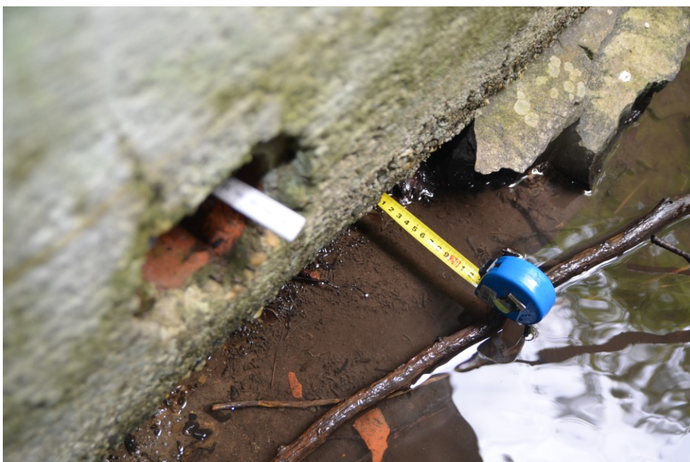
Obr.G45-18 Detail podemletí pravé části paty druhé podpěry, levobřežní opěry.,
