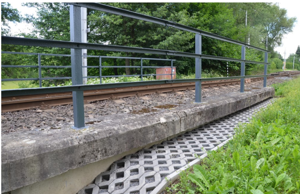
Obr.G41-07 Prodloužení začátku levého křídla 1. podpěry, vřesinské opěry. Pohled zleva doprava a proti směru staničení,
