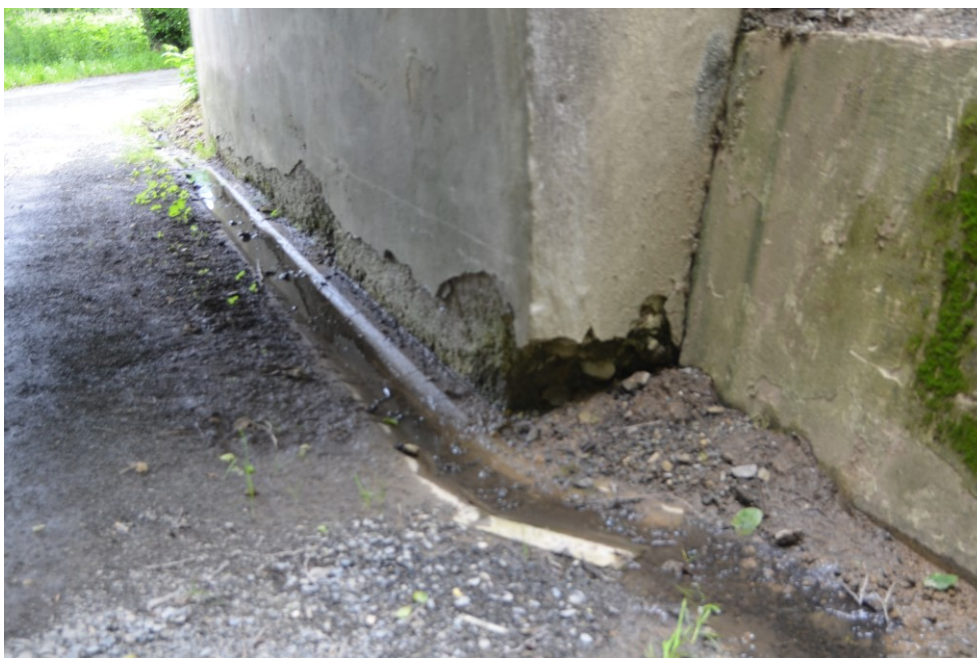
Obr.G41-21 Odvodňovací žlab vedený při patě líce 1. podpěry, vřesinské opěry. Pohled zleva doprava, proti směru staničení a dolů,
