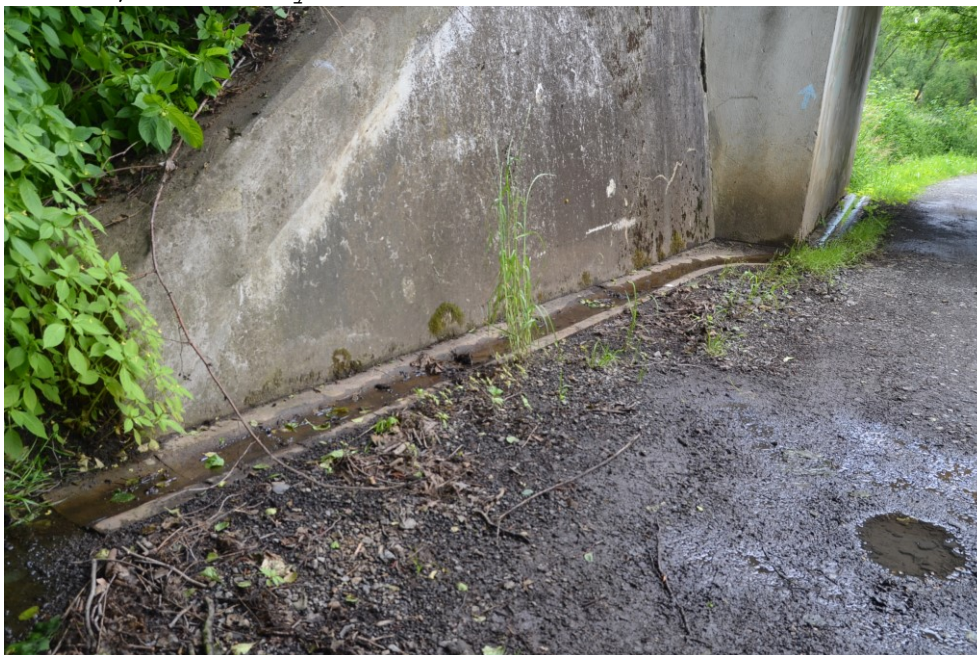
Obr.G41-22 Odvodňovací žlab vedený při patě levého křídla 2. podpěry, plzeňské opěry a dále při patě samotné opěry. Pohled ve směru staničení, zleva doprava a dolů,
