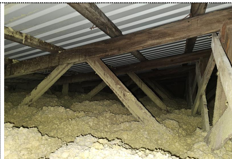
Obr. 3 Nosná konstrukce sedlové střechy severní části tvořená dřevěnými sbíjenými vazníky [P1]
