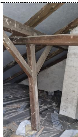
Obr. 3 Spojení sloupů, pásků, kleštin a krokví [P1]
