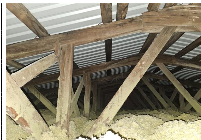
Obr. 2 Nosná konstrukce sedlové střechy severní části tvořená dřevěnými sbíjenými vazníky [P1]
