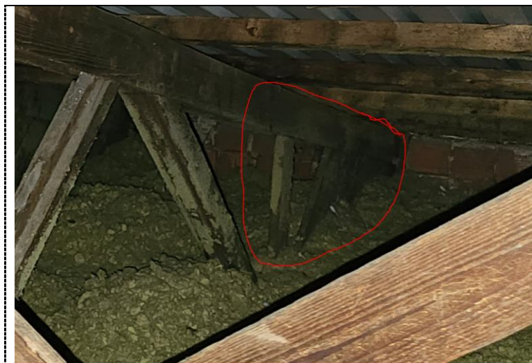
Obr. 7 Mírně zkroucený horní pás vazníku jižní části MŠ [P1]
