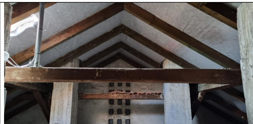
Obr. 2 Plné a jalové vazby krovu [P1]
